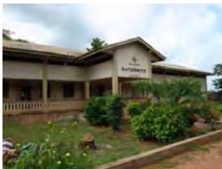
産科棟 敷地一番奥にある産科棟。
