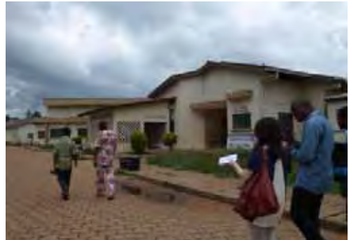
分娩棟 隣に産科病棟があり、分娩棟は別棟になっている。
