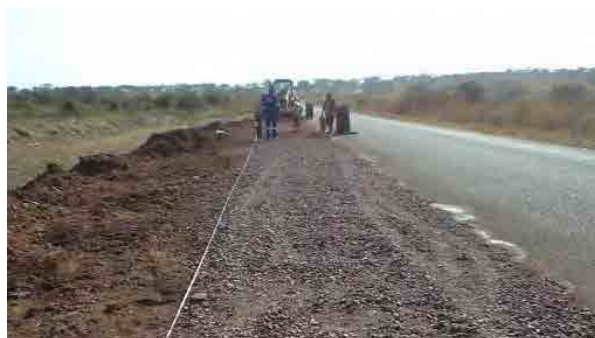
パイロットプロジェクト区間における施工状況
