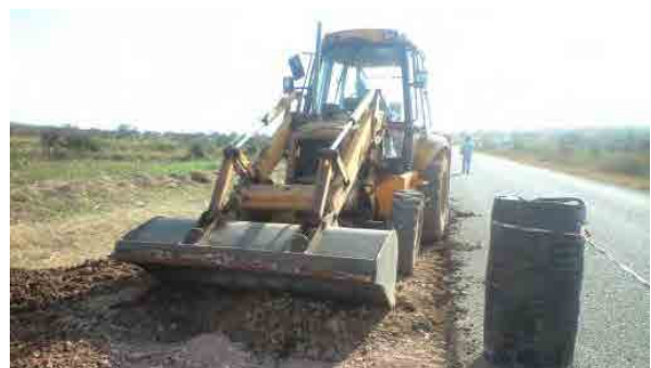
パイロットプロジェクト区間における重機を用いた補修作業
