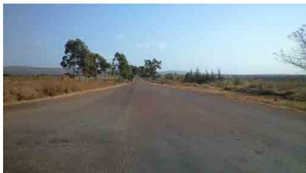
2014年5月から行われているパイロットプロジェクトの対象区間入口（マプト州インパト）
