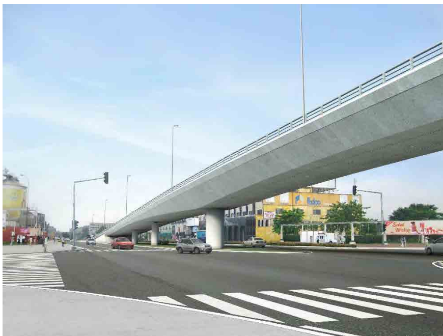
Vue sur le Boulevard VGE vers l'Ouest
