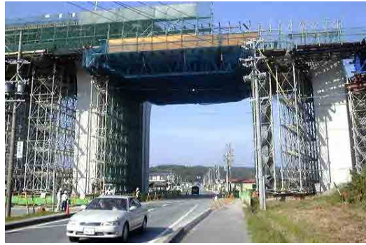
Photo 2-3 Exemple de mise en œuvre par étaieage spécial
