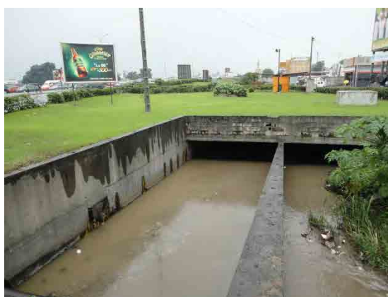
Photo 2.2-1 Grand canal de drainage qui sera le point d'évacuation final
