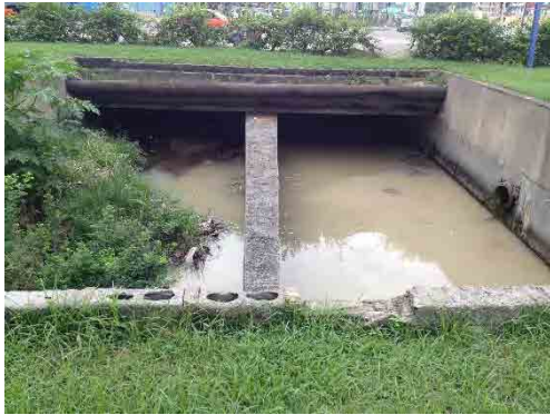
排水管理口（交差点北東側）
