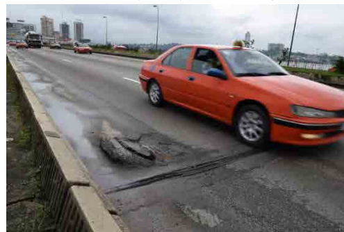
ドゴール（第2）橋 伸縮目地部
