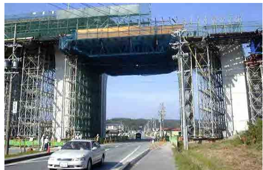
写真 3-3 特殊支保工施工例
