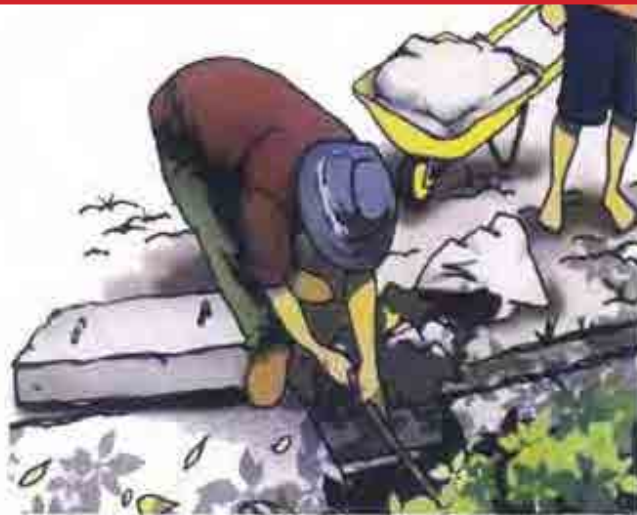
Gambar 5.5 Pembersihan Sedimen Di Saluran Tertutup
