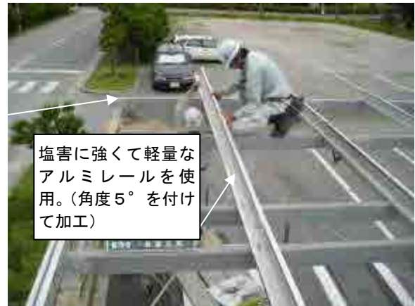
アルミレール施工の様子
