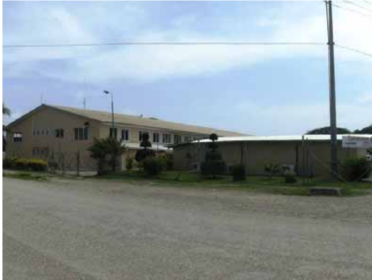
写真1. ソロモン諸島電力公社 本社屋(左側の建物)
