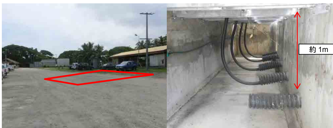
駐車場入口側から見た設置地点
