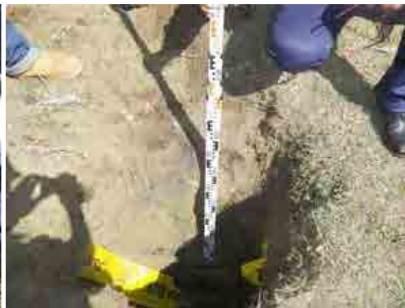
6月24日 埋設ケーブルの確認
