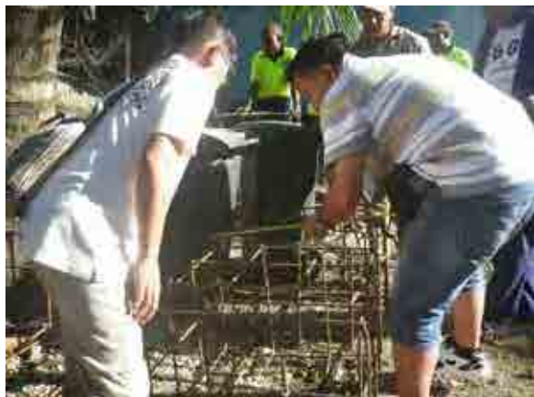
6月23日 基礎配筋の確認
