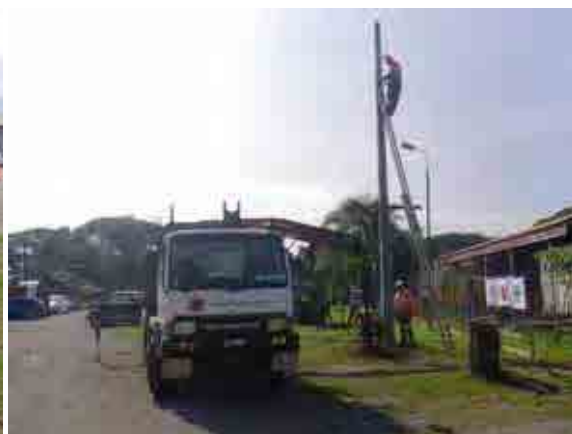
6月25日 ポール撤去作業
