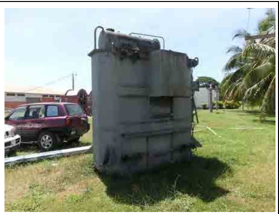
PV サイト仮置き資器材撤去
