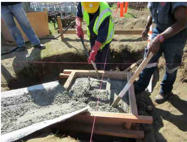
据付工事の様子
