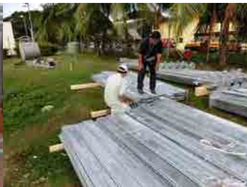
資機材の確認状況
