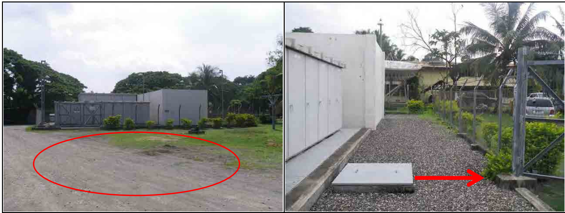
図 2-4 コンテナの仮置き場、埋設高圧ケーブルルート
