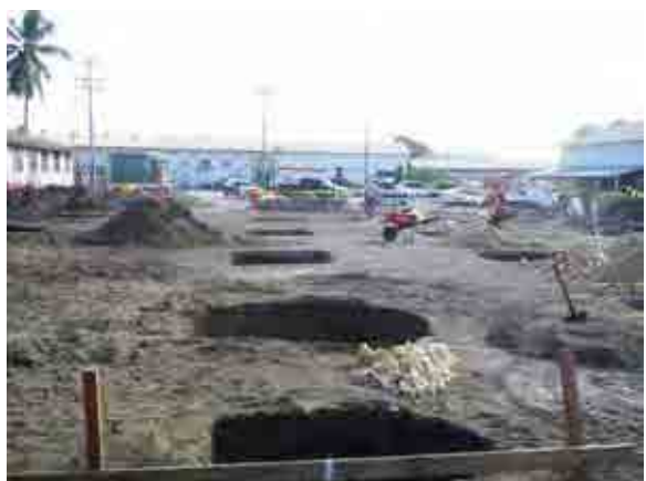
6月27日 掘削の状況
