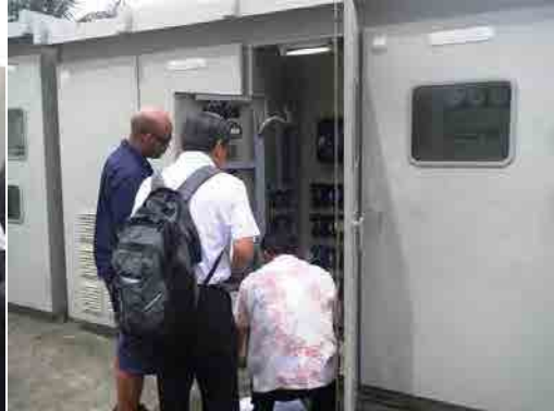
連系点となる既設盤内の確認
