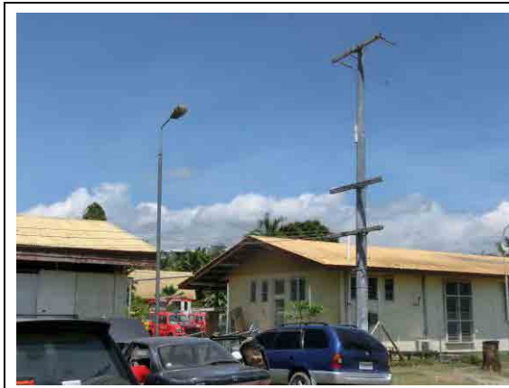
電機ポール及び照明ポールの移設
