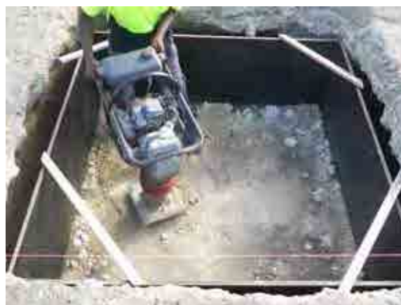
6月27日 転圧作業
