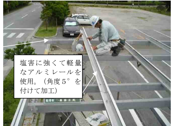
アルミレール施工の様子
