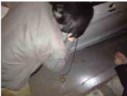
Geophone による漏水特定作業
