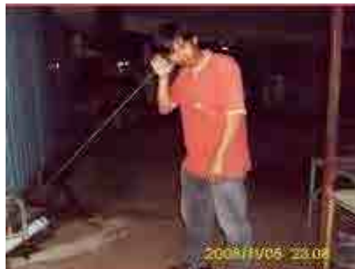
PWA における漏水調査風景 (音聴棒)
