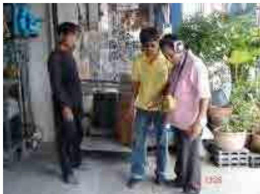
PWA における漏水調査風景 (音聴式漏水探知機)
