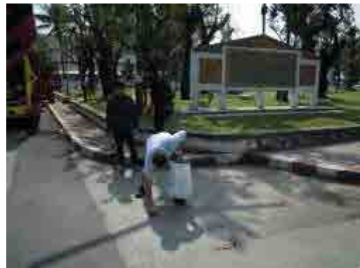
漏水可能性箇所
