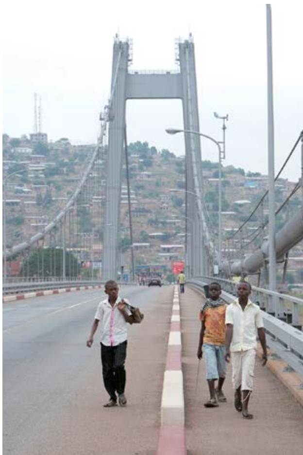
Le seul pont traversant le fleuve Congo a été construit grâce à un prêt d'APD en 1983. La JICA déploie actuellement une aide pour renforcer les capacités de maintenance du pont. (Photo : Shinichi Kuno)
