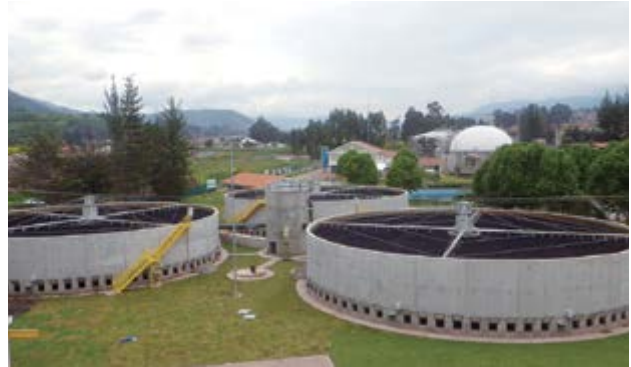
Usine de traitement des eaux usées à Cusco financée par un prêt d'APD (Pérou).
