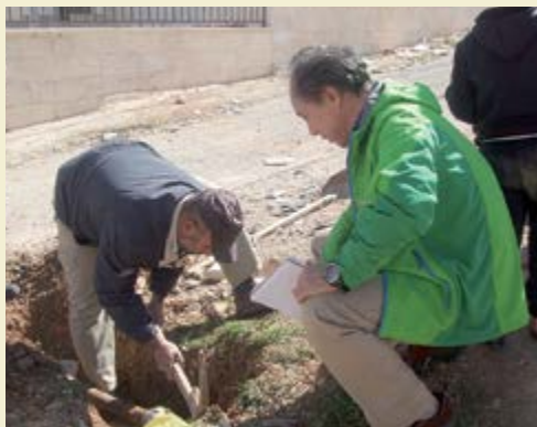
Un expert de la JICA vérifie l'état d'une canalisation au cours d'une analyse de la situation des services d'approvisionnement en eau et d'assainissement dans les communautés hôtes.
