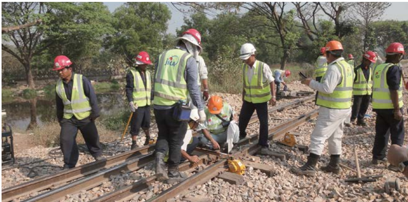
Myanmar : Formation aux techniques de mesure de l'écartement des rails dans le cadre du projet d'amélioration des services et de la sécurité ferroviaires.
