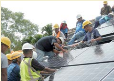
Installations de panneaux solaires en Micronésie.
