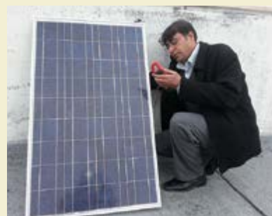
M. Osama travaille sur l'installation de générateurs solaires.
