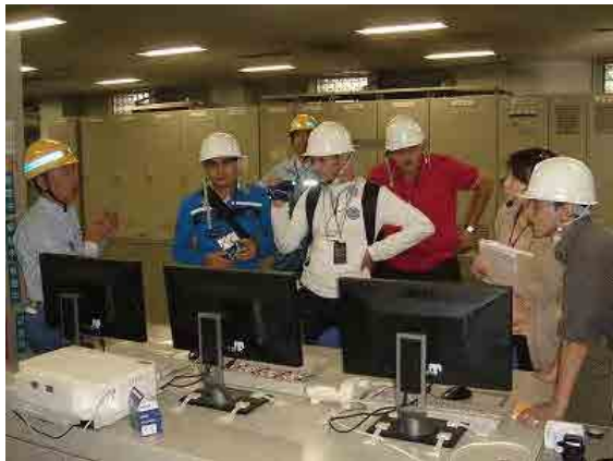
WDM本邦研修における横浜市水道局の管理・総合監視システム研修。(2012年11月)
