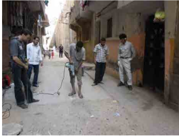
図 4.2-6 GHAPWASCO のドリルによる穿孔確認調査
