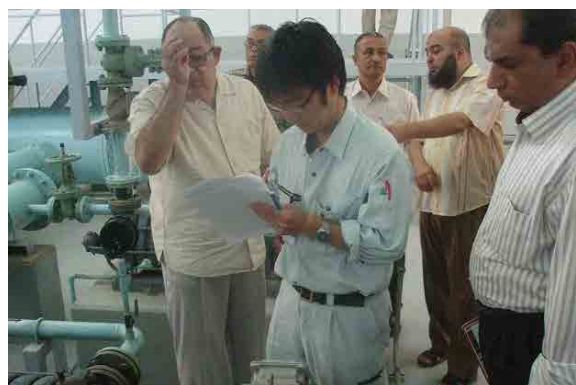
各浄水場施設における現状把握調査。(2011年10月)
