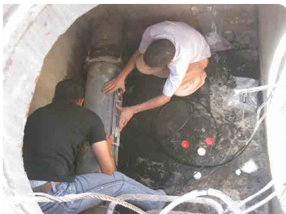
流量モニタリングチャンバーに設置された流量計。 (2013年5月)
