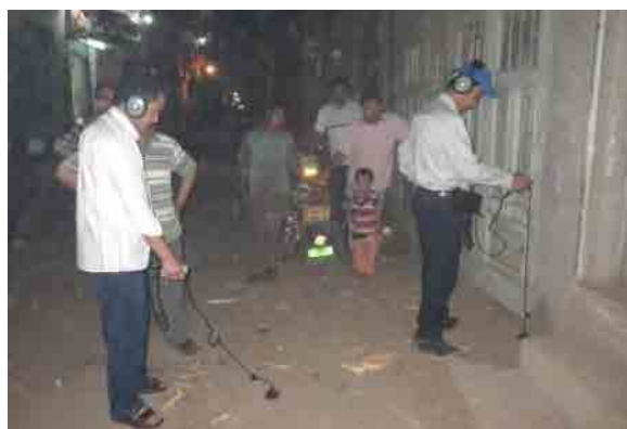
図 4.2-5 GHAPWASCO の漏水探知器を使用した路面音聴調査
