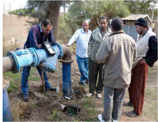
Ashama井戸施設におけるMCWWのNRWチームと合 同での流量調査。(2012年12月)
