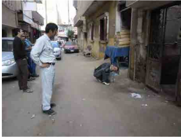
図 4.2-16 MCWW のドリルによる穿孔確認調査
