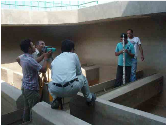
Tanta El Teraa El Melahia表流水浄水場における排水 トラフの越流レベルを調整。(2012年10月)
