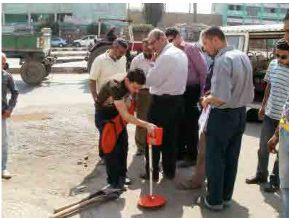
SHAPWASCOのC/Pメンバーによる埋没したバルブチャンパー蓋の金属探知機による探査。(2011年10月)
