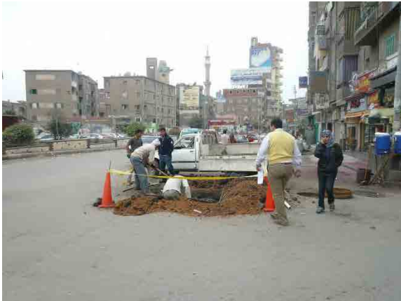
流量計チャンバーの建設現場。(2012年12月)
