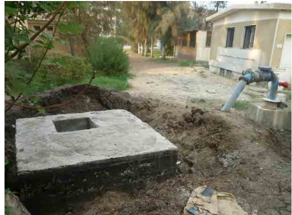
建設された流量計チャンバー。(2012年12月)
