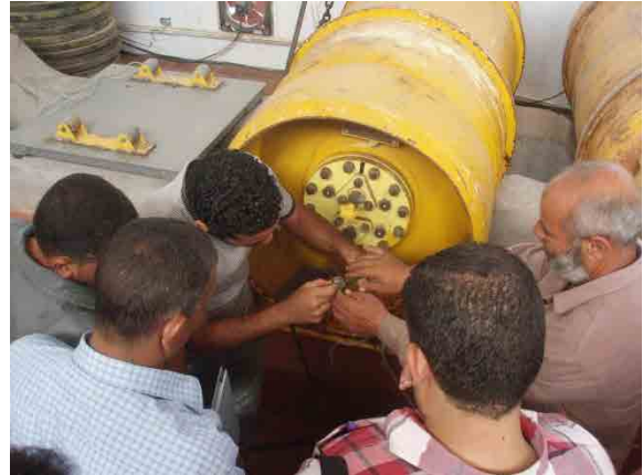
GHAPWASCO及びMCWWのC/Pメンバーによる塩素 ポンベの整備技術の共有。(2012年9月)
