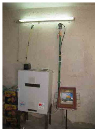
圧力計とそのテレメータ装置。(2013年5月)
