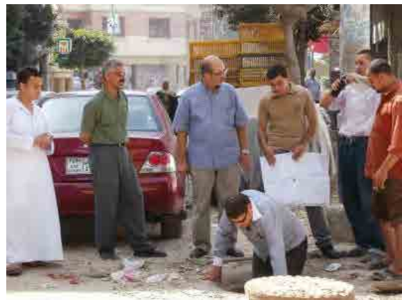
SHAPWASCOのC/Pメンバーによるバルブ状況調査。(2011年10月)
