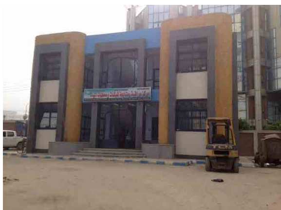
完成したWDM中央監視棟。(2014年3月)
