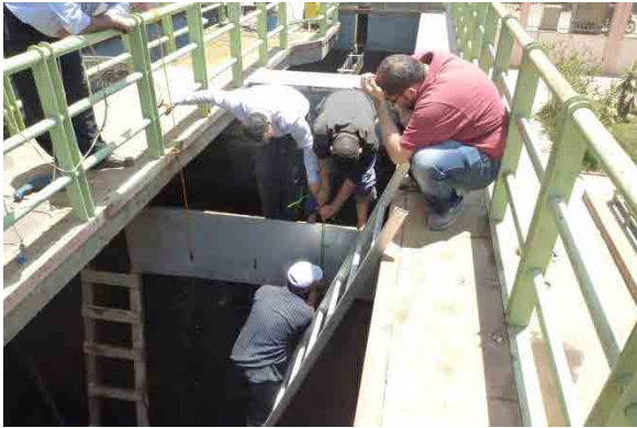
Gezy鉄・マンガン除去施設における沈殿池越流堰のレベル調整。(2013年5月)
