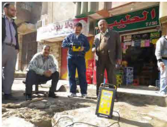
図 4.2-4 GHAPWASCO の相関式漏水調査
