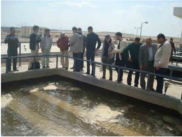
JICA終了時評価におけるSOP現場視察。(2014年2月)
