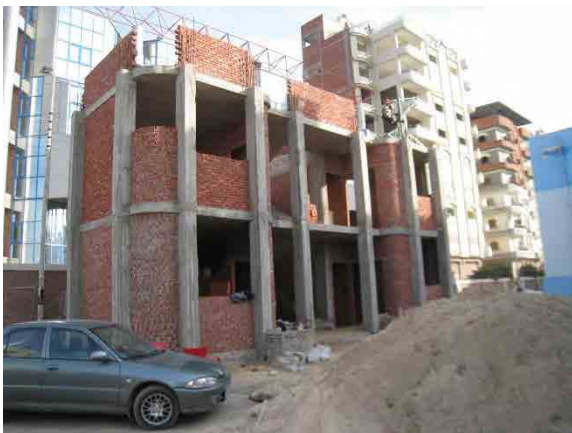
建設中のWDM中央監視棟。(2013年2月)
