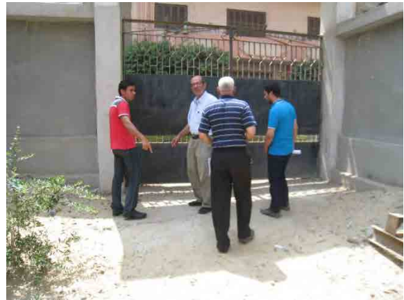
WDM圧力計設置箇所の現場調査。(2012年7月)
