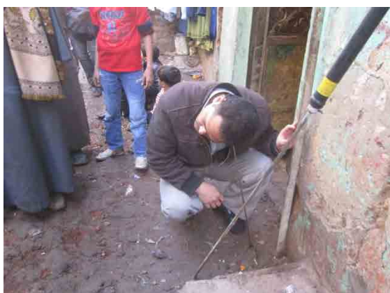
Zefta郡におけるボーリングバーと音聴棒による漏水確認調査。(2013年1月)
