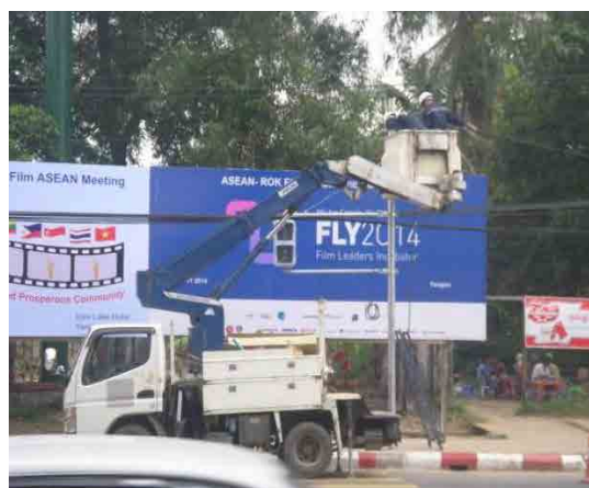
歩行者用灯器設置工事
