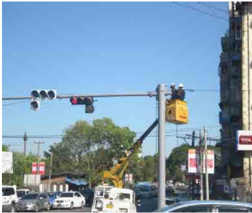
CDG交通点での機材設置工事
