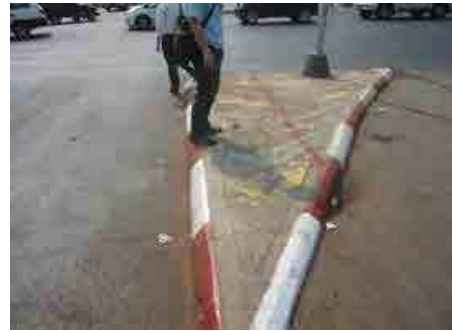
S5 交差点：導流島を削り、1車線増線
