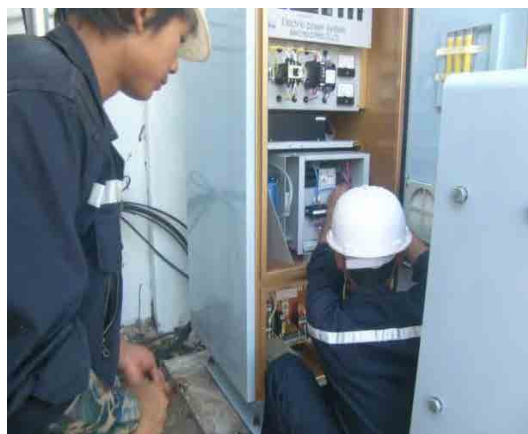
UPS（無停電電源装置）配線工事
