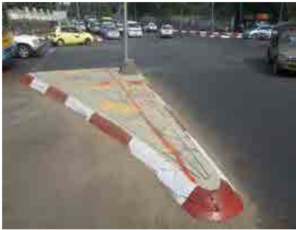
S5 交差点：導流島削除前
