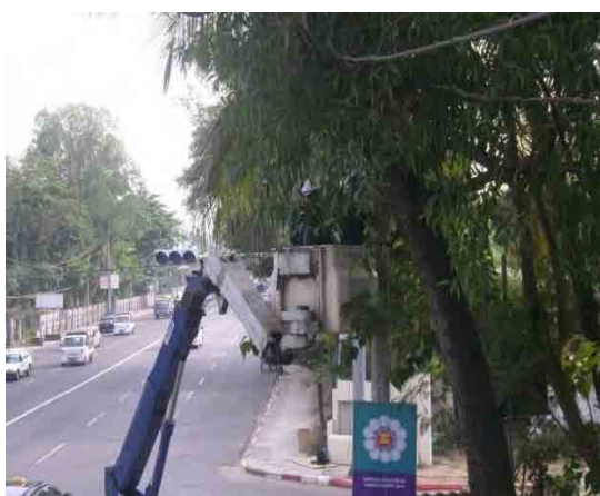
架空線張り上げ工事
