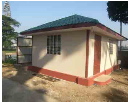
専用サーバールーム新設
