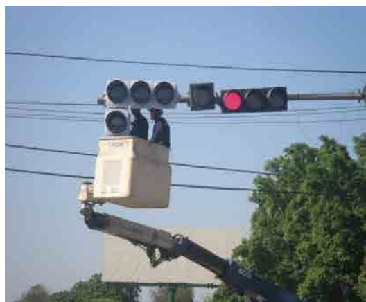
灯器（左）新設設置工事
