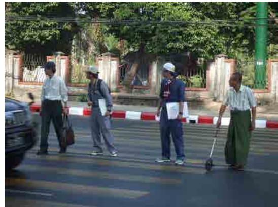
NEW1交差点での道路測量
