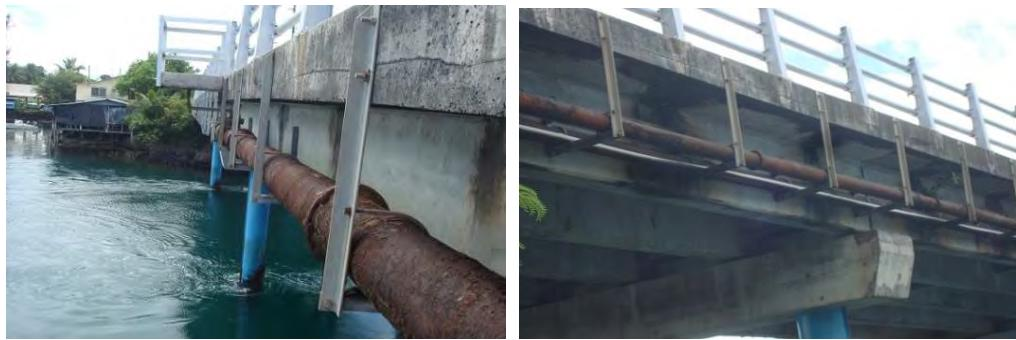
[左]ミナトバシ西側（既存下水道管）、[右]ミナトバシ東側（既存配水管 DN4in (100mm)、2 本）
