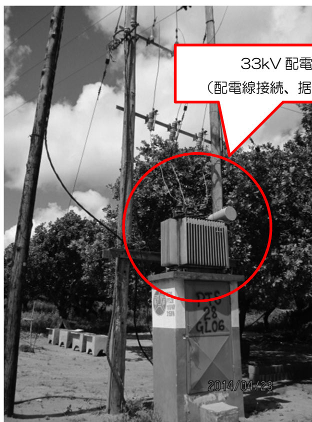
図 3-13 33kV 配電用変圧器のイメージ
