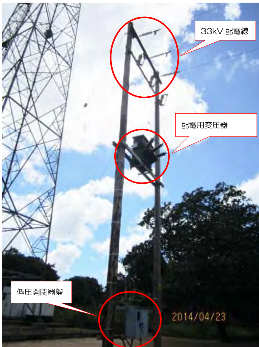
図 3-15 配電用変圧器設置例
