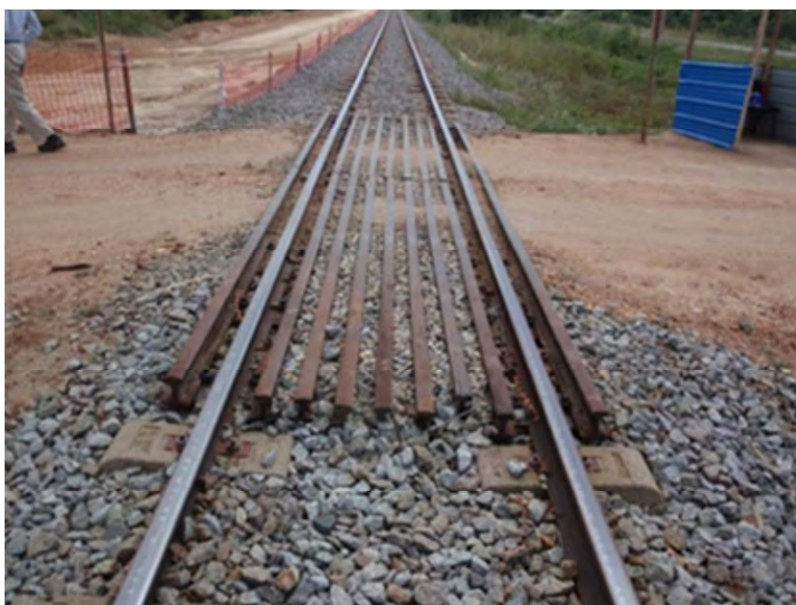
図 3-19 鉄道横断部施工例（国道 12 号線沿に所在）
