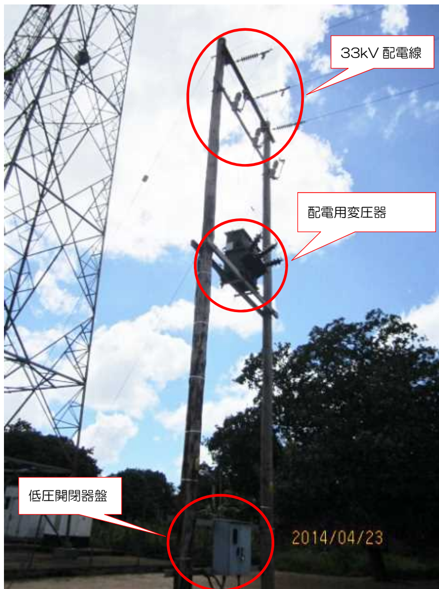
図 3-15 配電用変圧器設置例
