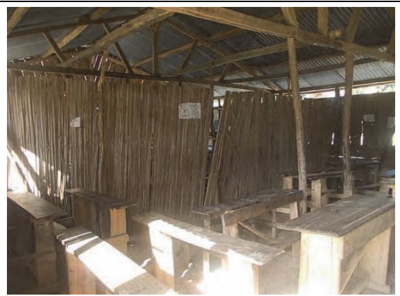
写真 I-6: 仮設教室内部。中央の間仕切りにより2教室として使用。
