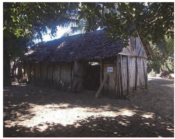
写真 I-4: 仮設教室棟。当該1棟を中央で区切り、2学級で使用している。
