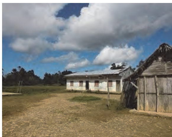
写真 I-7: 継続使用可能な教室 (左) と仮設教室 (右)。 (VA-8 EPP Mahatsara)
