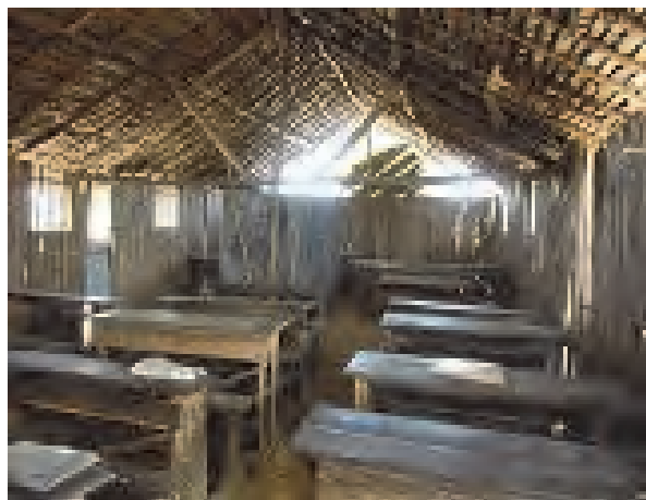
写真 I-3: サイクロン被害への対応として、保護者会により設置された仮設教室。
