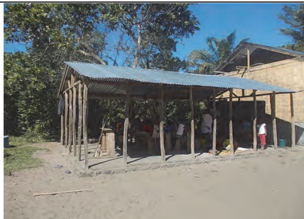
写真 I-5: 教室不足により設置された仮設教室。壁がなく、悪天候時の授業運営は容易ではない。
