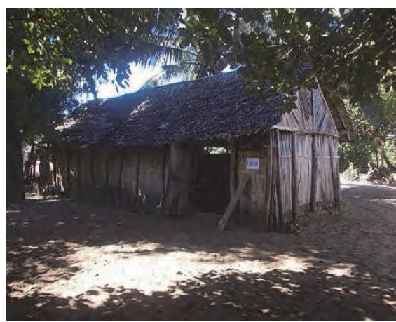
写真 I-4: 仮設教室棟。当該1棟を中央で区切り、2学級で使用している。
