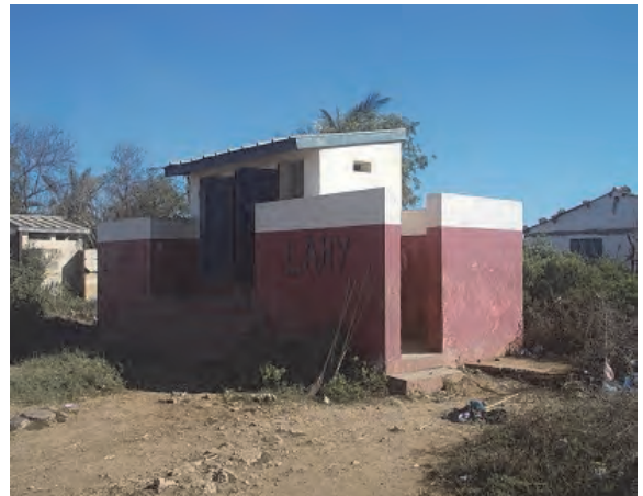
写真III-2： 第三次案件によるトイレ棟。外壁の損傷が比較的少ない。 (EPP Anketa)
