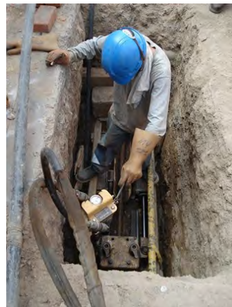
円借款事業「リマ首都圏北部上下水道 最適化事業」工事現場②
