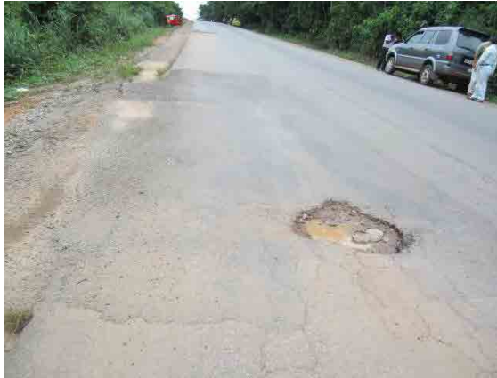
写真-19：地方部輸送幹線道路（山地部）
