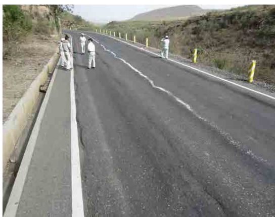
写真-4：地方部輸送幹線道路（山地部）
