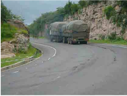
急勾配で曲線半径の小さな区間であるため速度は10km/h以下である。
