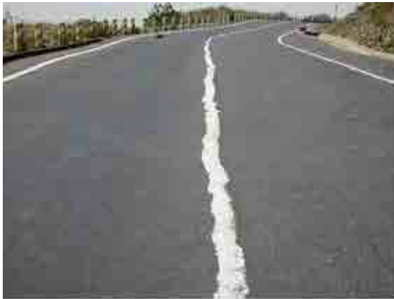
写真-16：地方部輸送幹線道路（山地部）
