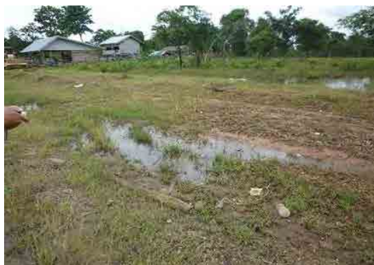
土側溝が埋まり滞水している状態
