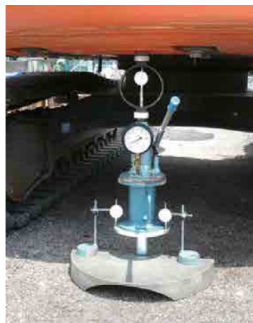
写真2 現場 CBR の様子（バックホーのボデーで反力を取っている）
