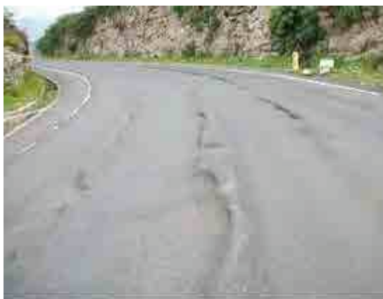
写真-6：地方部輸送幹線道路（山地部）
