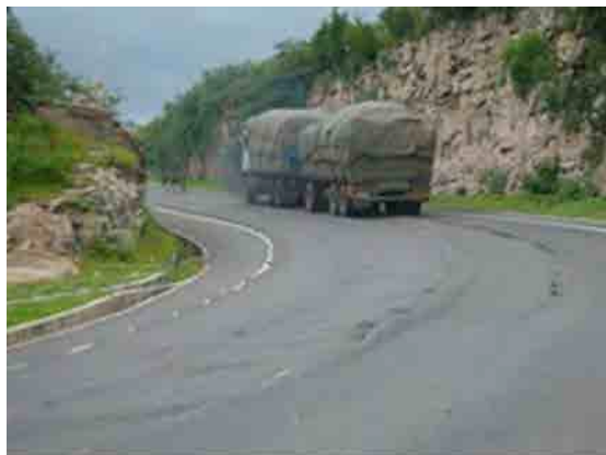
写真-11：急勾配で曲線半径の小さな区間で速度 10km/h 以下で走行する車両
