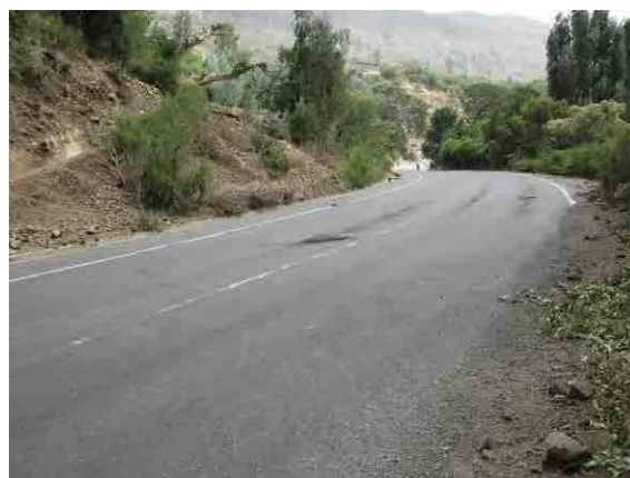
写真-5：地方部輸送幹線道路（山地部）
