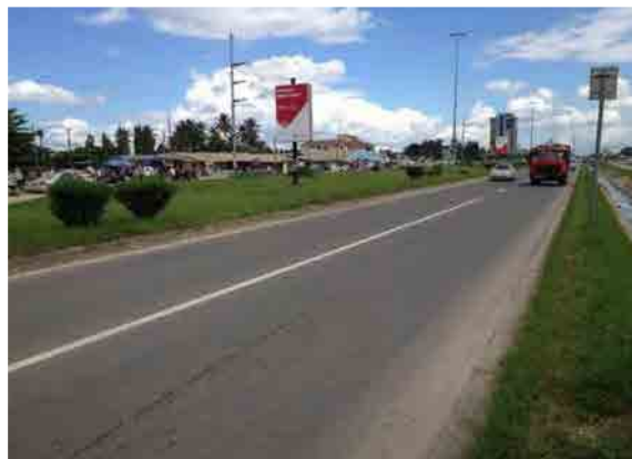
軸重測定を実施したネルソン・マンデラ道路
