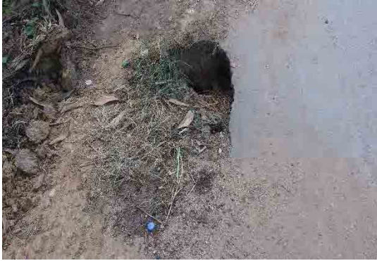
写真 5.1 発生したドラゴンホール
