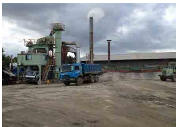
アスファルト合材のサンプルを採取したプラント
