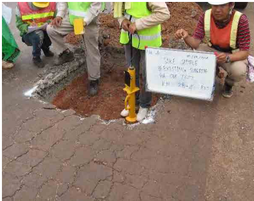
写真 4.10 現場 CBR 確認状況
