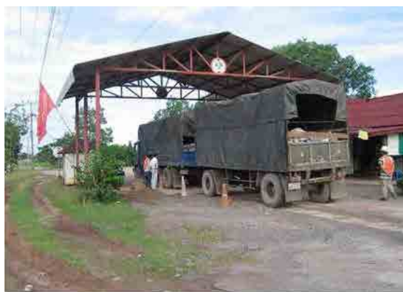
ラオス国 軸重計測所 (国道9号)
