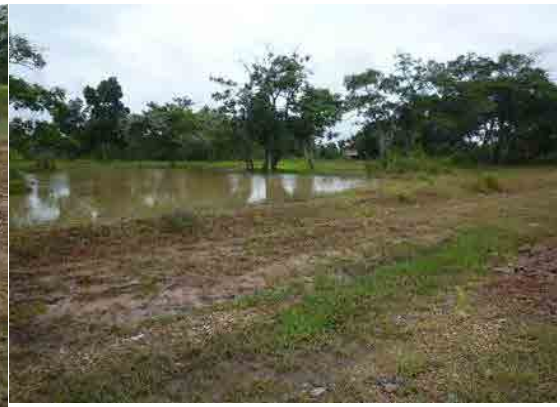
写真 5.10 沿道部の滞水 (雨季のみに発生)
