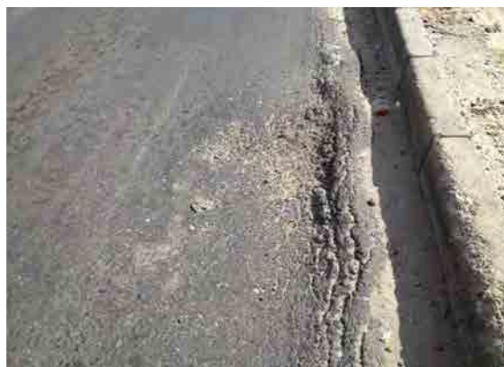
中央分離帯に近傍にわだち掘れ(側方流動)交通量測定箇所
