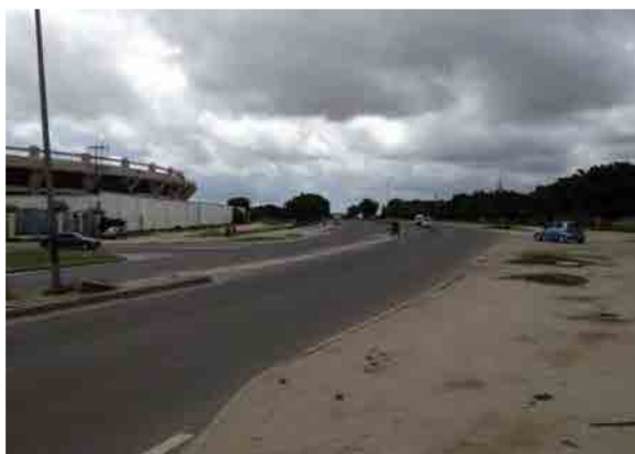
ダルエスサラーム港と国内主要路線を結ぶネルソン・マンデラ道路。軸重測定箇所
