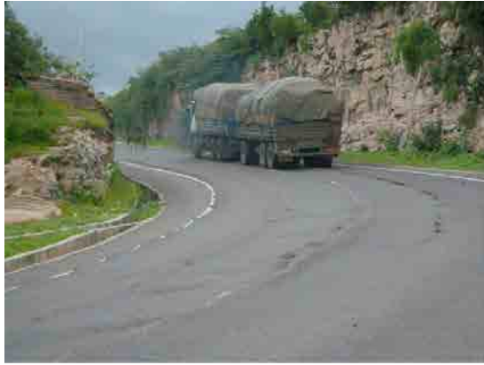
急勾配で曲線半径の小さな区間であるため走行速度は10km/h以下である。
