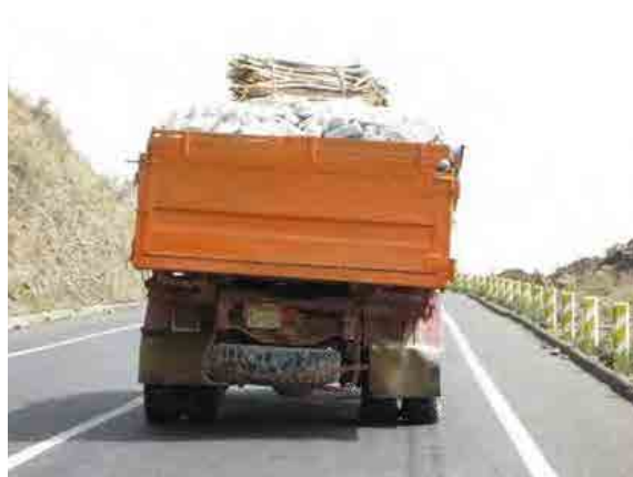
低速重量車両によるバインダーの染み出し
