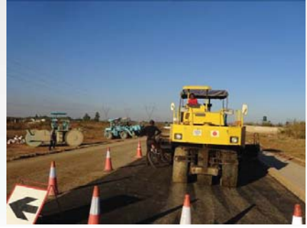
Inner Ring Road工事(日本無償)
