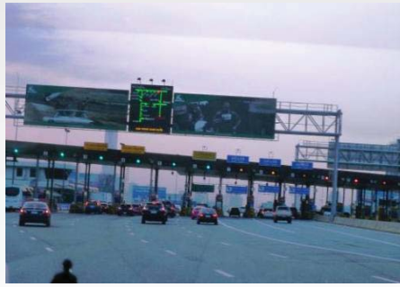
高速道路料金所、VMS
