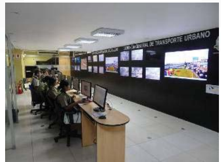
カヤオ市交通管制センター
