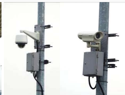
LEKKI有料橋CCTV
