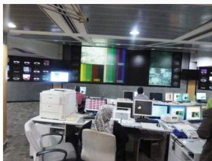
KL市信号管制センター
