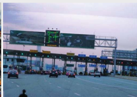
高速道路料金所、VMS
