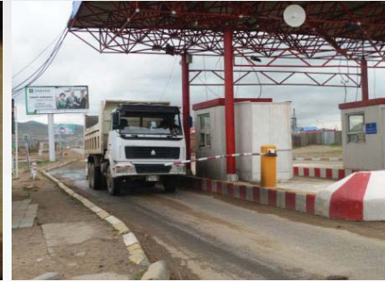
料金徴収所(県間道路)
