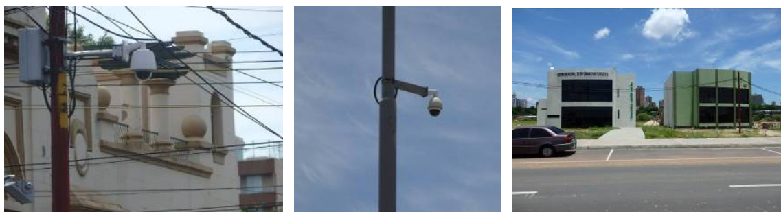
図 10-32 CCTV(中央は Costanela 高速道路の CCTV、右写真の右側施設が KOICA 無償による交通管制センター)
