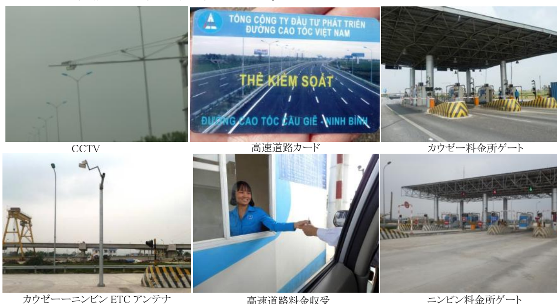
図 3-29 ベトナム高速道路のITS 関連施設・機器
