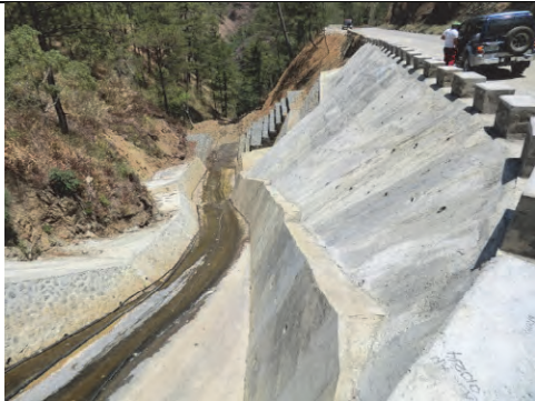
コルディレラ行政リージョンにおける道路斜面管理 パイロット工事の完工後の状況
