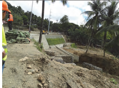
セブの道路斜面管理パイロット工事。本邦企業製品（ジ オテキスタイル）による補強土表面の植生状況は良好
