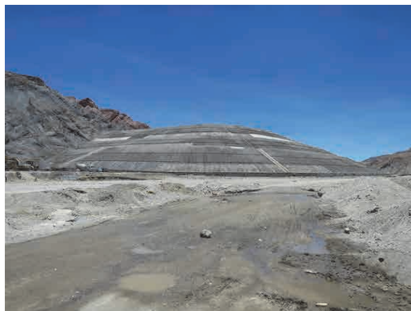
Foto 4-54 Dique de Colas de Telamayu (Río Blanco)
