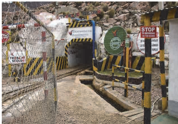
Foto 4-33 Aguas residuales de la entrada a la mina Colquechaquita
