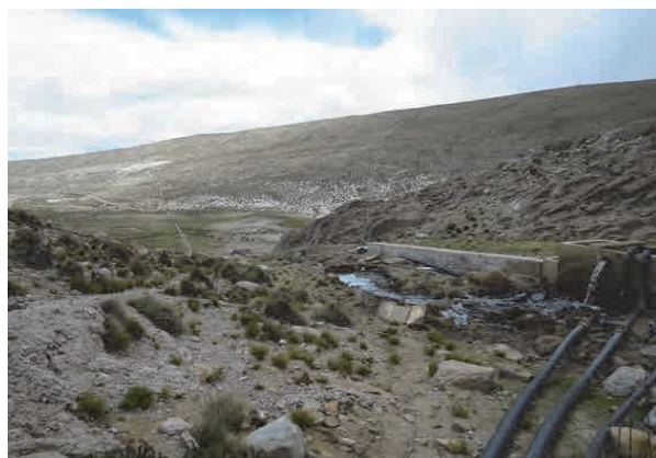
Foto 4-34 Desagüe de aguas neutralizadas de la mina Colquechaquita
