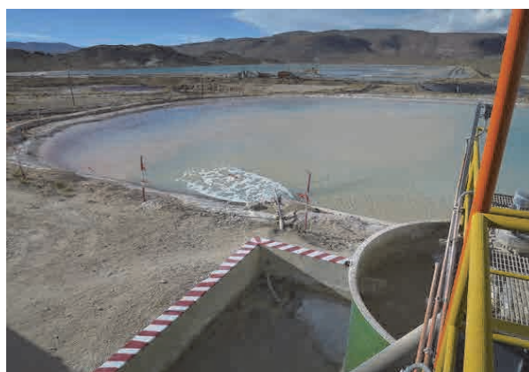
Foto 4-42 Dique de colas mina Sinchi Wayra
