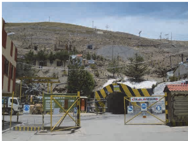
Foto 4-11 Bocamina (Rampla de entrada de camiones)
