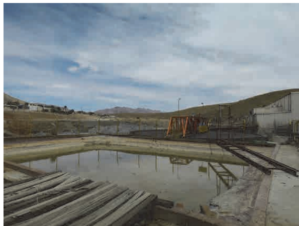
Foto 4-10 Instalaciones de la mina (Estanque de drenaje y planta de concentración)
