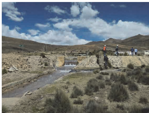
Foto 4-30 Aguas alcalizadas del drenaje de la Mina San Lorenzo
