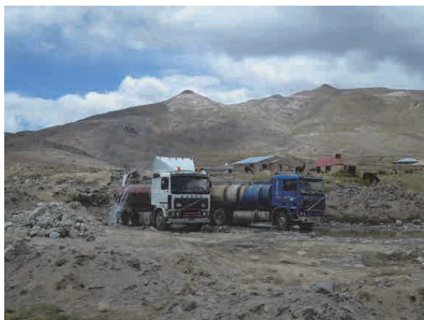
Foto 4-31 Suministro a carros sistema del drenaje de la mina San Lorenzo
