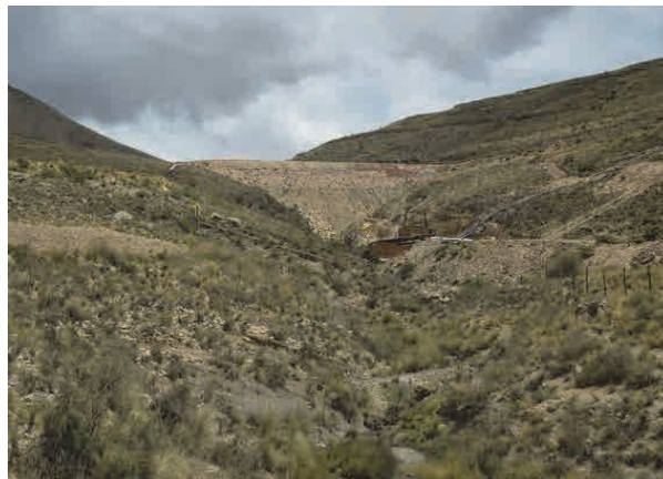
Foto 4-36 Aguas vertidas desde la planta concentradora Junji directamente al río
