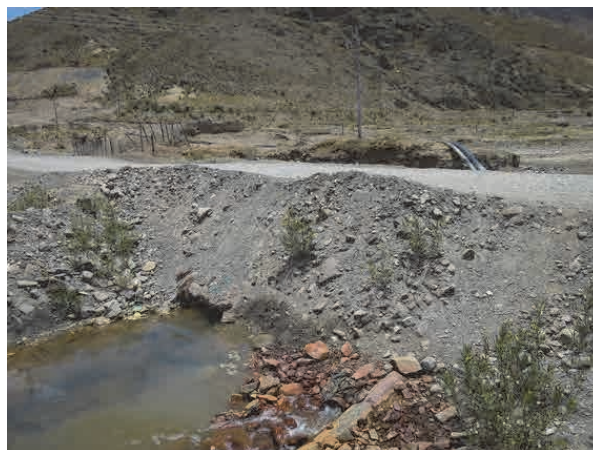
Foto 4-14 Desagüe de aguas de mina Poopo al río
