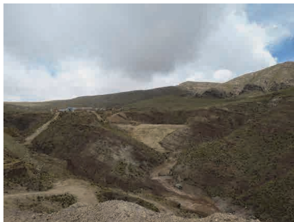
Foto 4-46 Presa de residuos afectado (Actualmente se encuentra en reparación)
