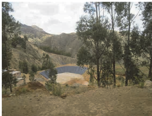
Foto 4-48 Dique de colas de la Cooperativa
