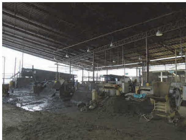
Foto 4-12 Planta de separacion y purificación de oro interior de la planta
