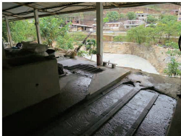
写真 5-68 金選鉱-精製場内
