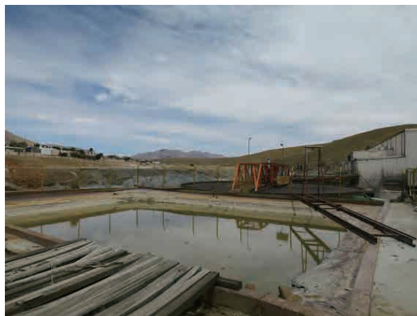
写真 5-10 鉱山施設（排水溜池及び選鉱場）
