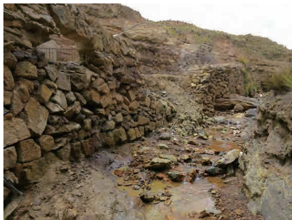
写真 5-44 坑内廃水の河川への直接排出
