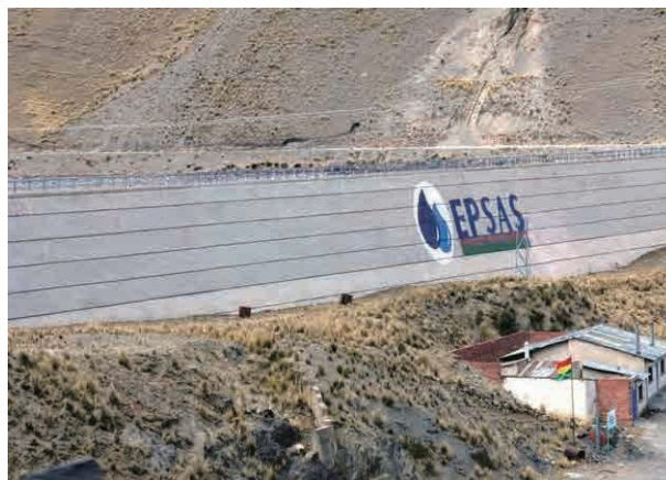
写真 5-60 採掘地直下のインカチャカダム （ラパス市の水源）
