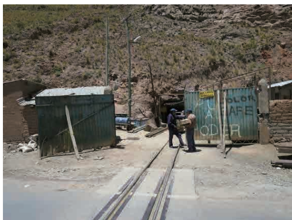
写真 5-5 ワヌニ鉱山坑口
