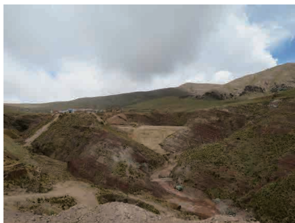
写真 5-46 決壊した尾鉱ダム（現在再建設中）
