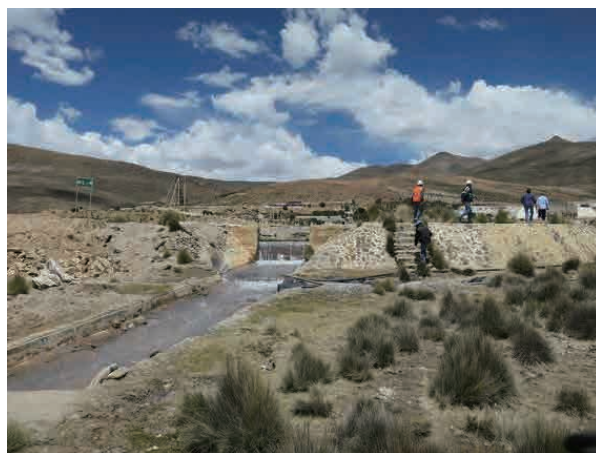
写真 5-30 サン・ローレンゾ鉱山 中和された排水のたい積池
