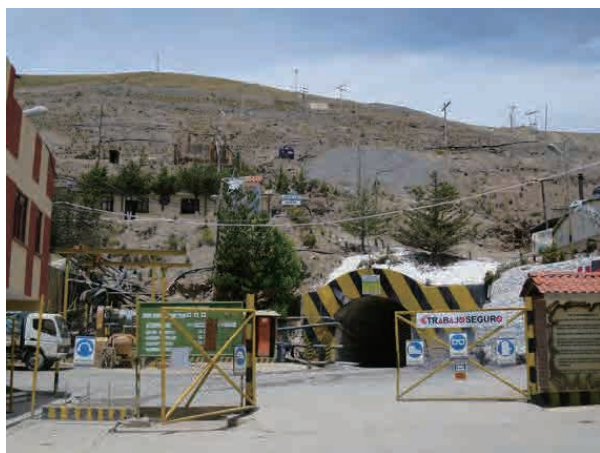
写真 5-11 坑口（トラックレス）
