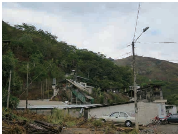
写真 5-63 Zaruma-Portovelo 金鉱山一部立坑
