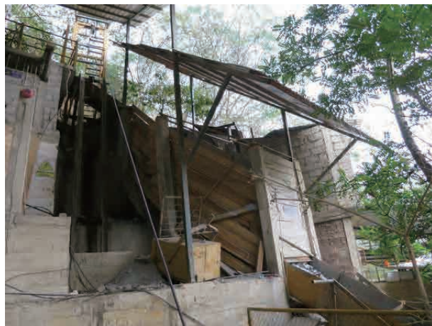
写真 5-64 立坑及び鉱石搬出場
