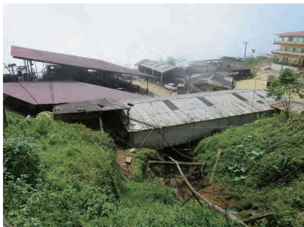
写真 5-71 Ponce Enriquez 金鉱山 金選鉱-精製場
