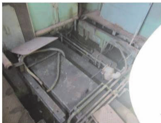
(f) 空気圧縮機 (コンプレッサ) 取り外し
