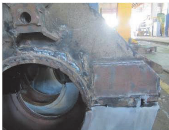
(f) 溶接による補修の状況
