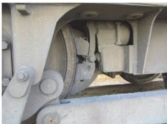
(a) 稼働中車両のブレーキ装置 (E1114)
