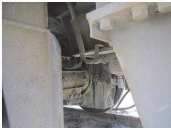
(c) 本線運行中の機関車 (E1114) の油漏れ
