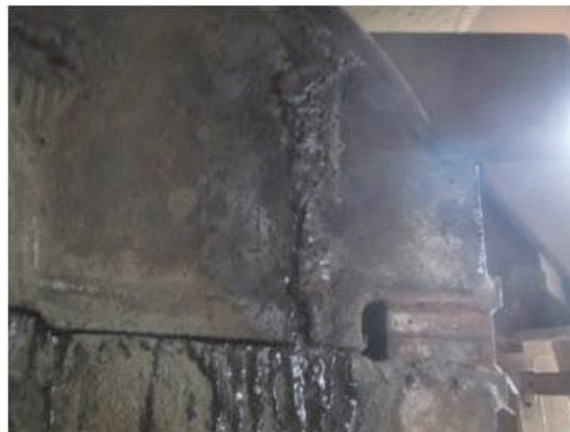
(d) 点検中の機関車 (E1113) の油漏れ
