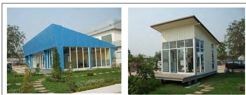
図 3-28 軽量鉄骨造モデルハウス
