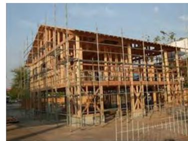
図 1-9 右：プレカット構造材による日本の在来木造建築構造
