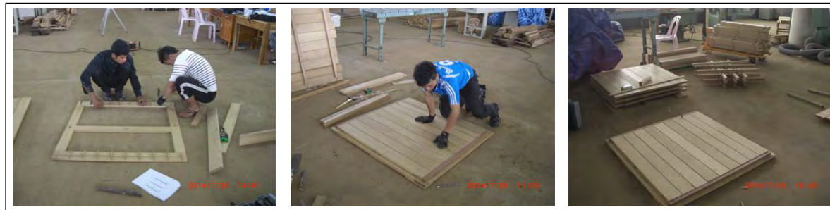
図 3-14 組み立てゲージの製作、仮組み
