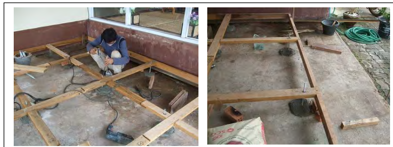
図 3-21 ウッドデッキの設置基礎工事
