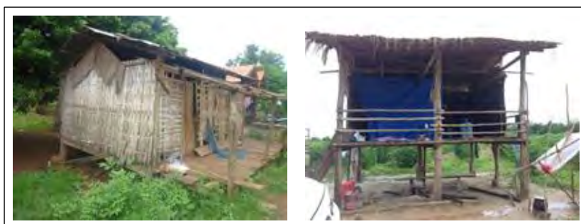
図 4-1 一般的な作業員宿舎
