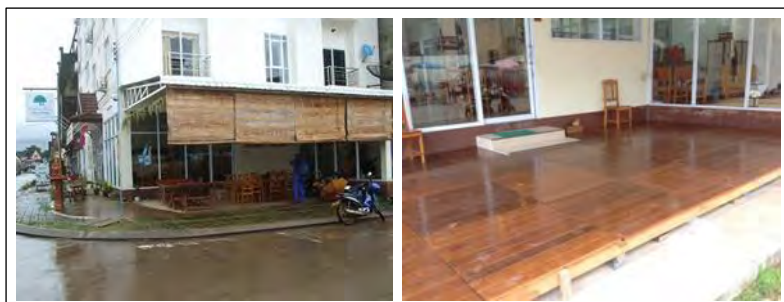
図 3-16 ウッドデッキの設置
