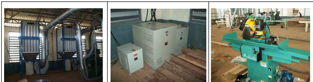
図 3-2 第 1 回目機材・設備搬入・据付・試運転
