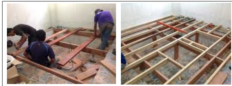
図 3-20 ホテルの改修工事現場実習
