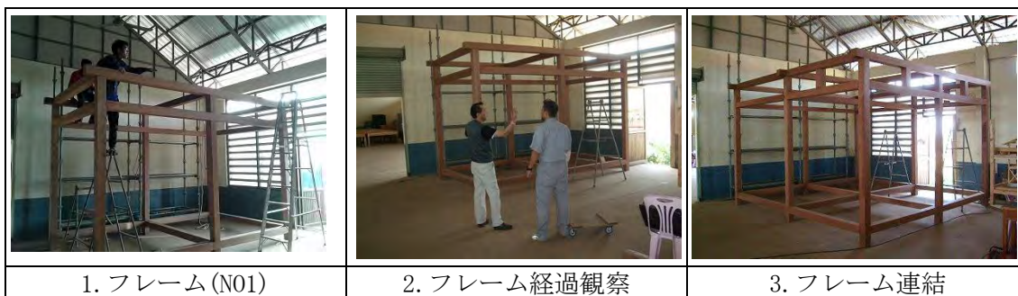
図 3-18 加工及び組立指導用住宅フレーム試作品
