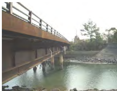
知多 2 号橋、愛知県半田市
