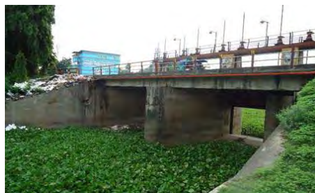
水門付き橋梁
