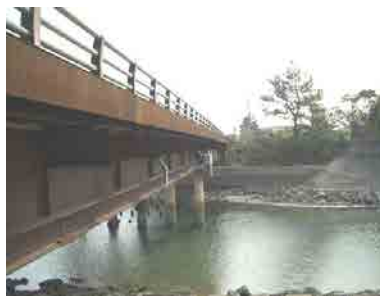
知多 2 号橋、愛知県半田市
