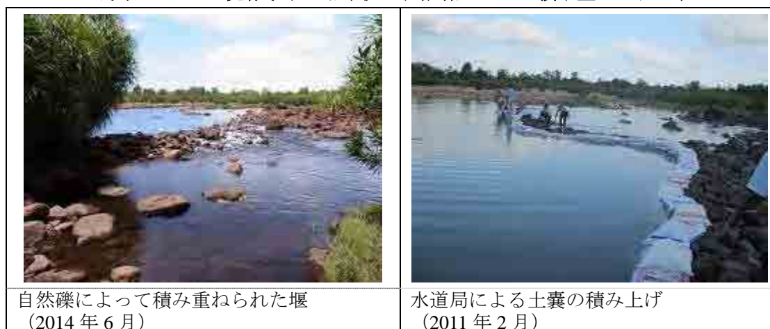
写真 3.2.2.2-2 既存取水地点下流の自然礫によって積み重ねられた堰
