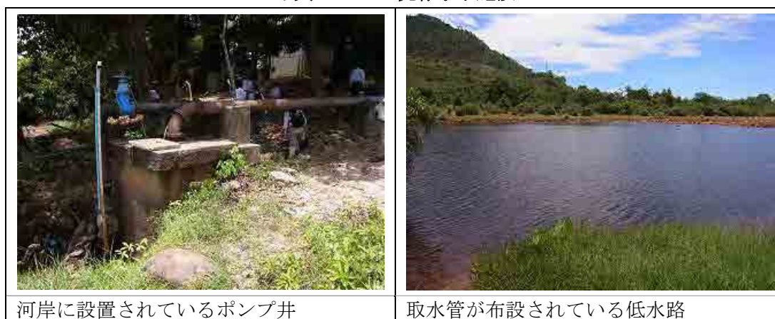
写真 2.1.6-1 既存取水施設
