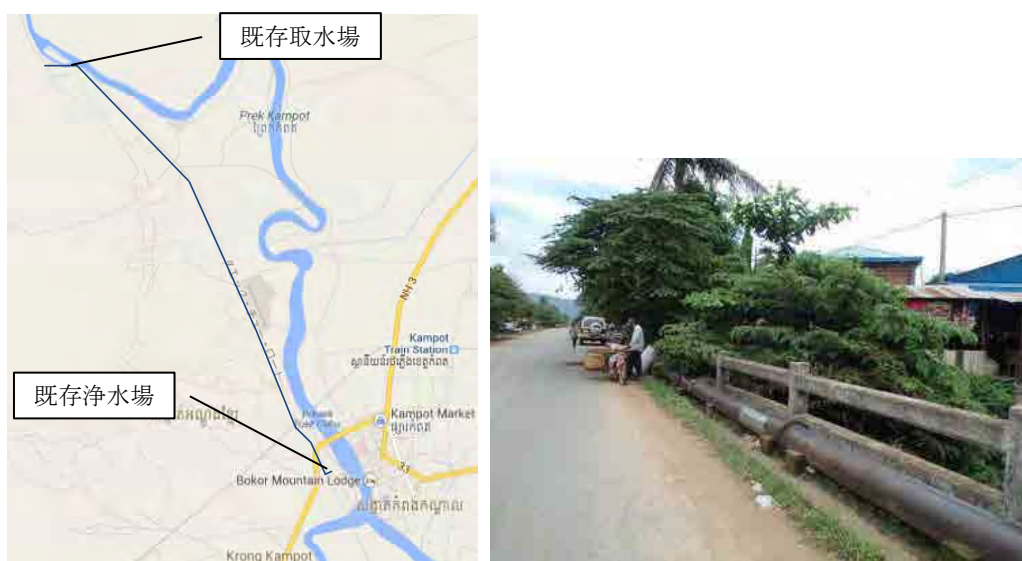
(左) 既存導水管ルート (右) 布設状況 (添架水管橋)
