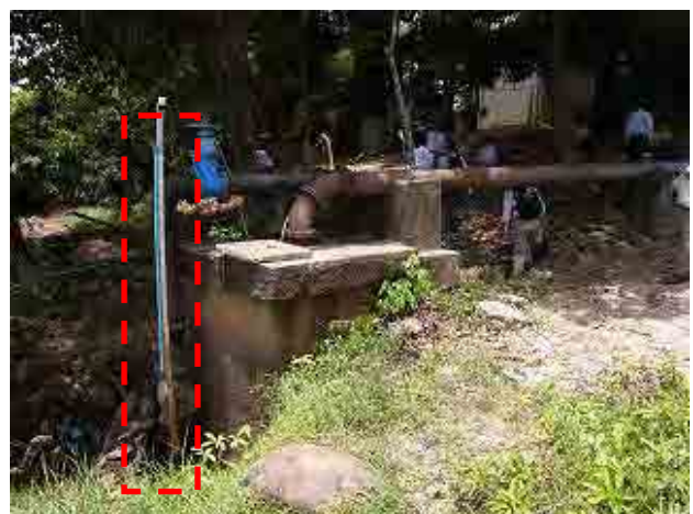
写真 2.1.6-2 既存取水地点の量水標
