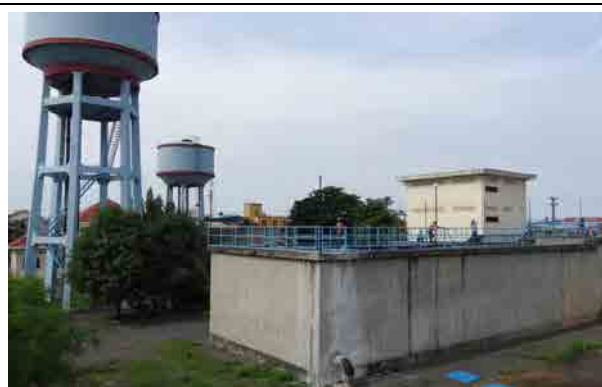
写真 1-2：カンポット市既設浄水場（2014年7月） 処理能力：5,760m 3 /日
