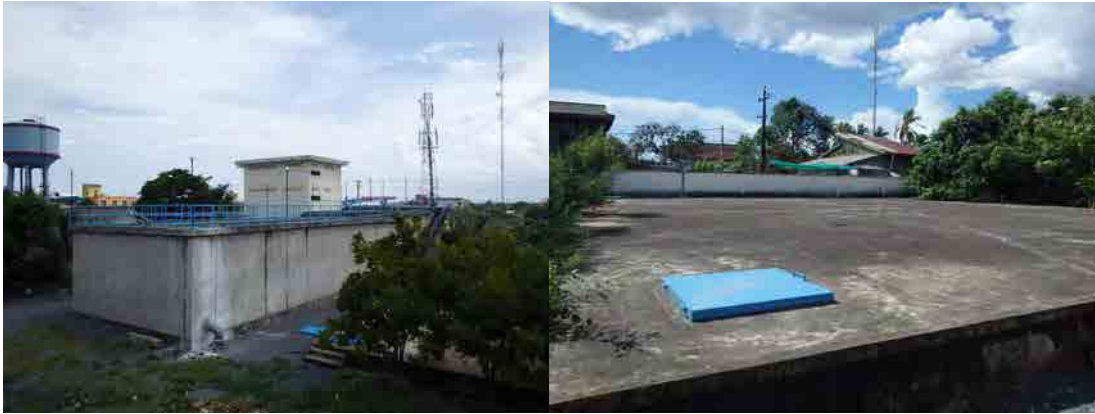
(左) ろ過池棟 (右) 浄水池
