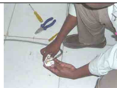
電源プラグの修理
