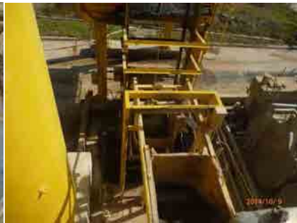
トロリーを上からみた状況
