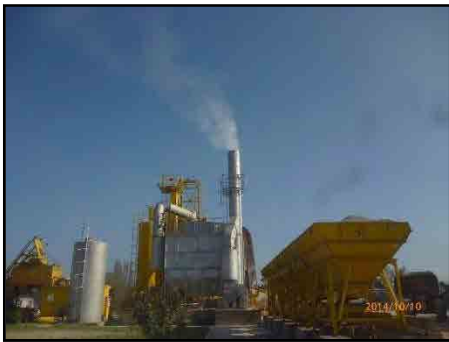
バグフィルタクロスの不具合で煙突からダスト
