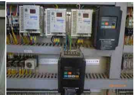
交換して新しくしたインバータ
