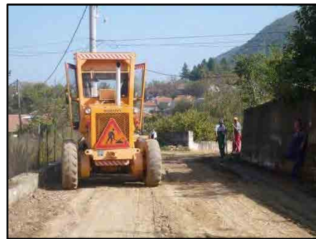
サイトで稼働中のモーターグレーダ
