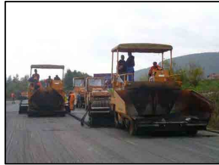
対象機材を使った舗装工事
