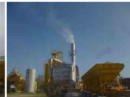
集塵装置全景その2(煙突からダストが出ている)
