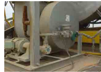
燃料ポンプ付近
