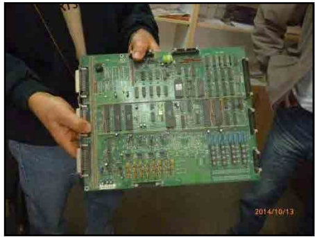
落雷で破損したコントロールパネル基板
