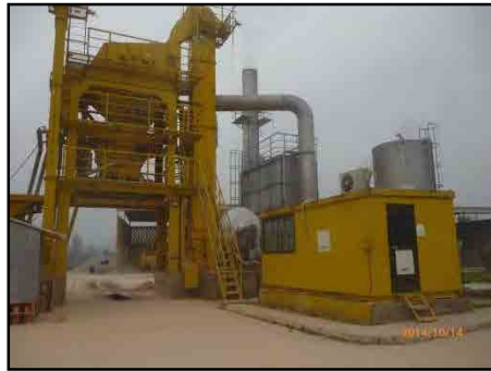
本体と手前右のコントロールルーム
