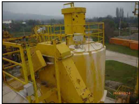
フィルターサイロにレベル計現地取付け
