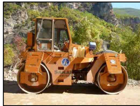
サイトで稼働中の10トン振動ローラ
