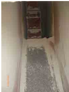
ファイラーエレベータのバケットと上部シュート
