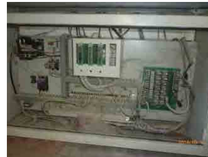
交換して新しくしたロードセルアンプ
