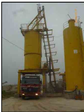
サージビン下のダンプに合材積み込み中
