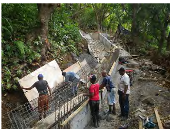
Les travaux de construction (à gauche: nouvelle chaîne, à droite: horizontale drainage)
