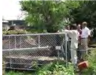
Suivi des mouvements de terrain de surface (par extensomètre)
