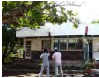
Vérification des maisons endommagées sur les lieux
