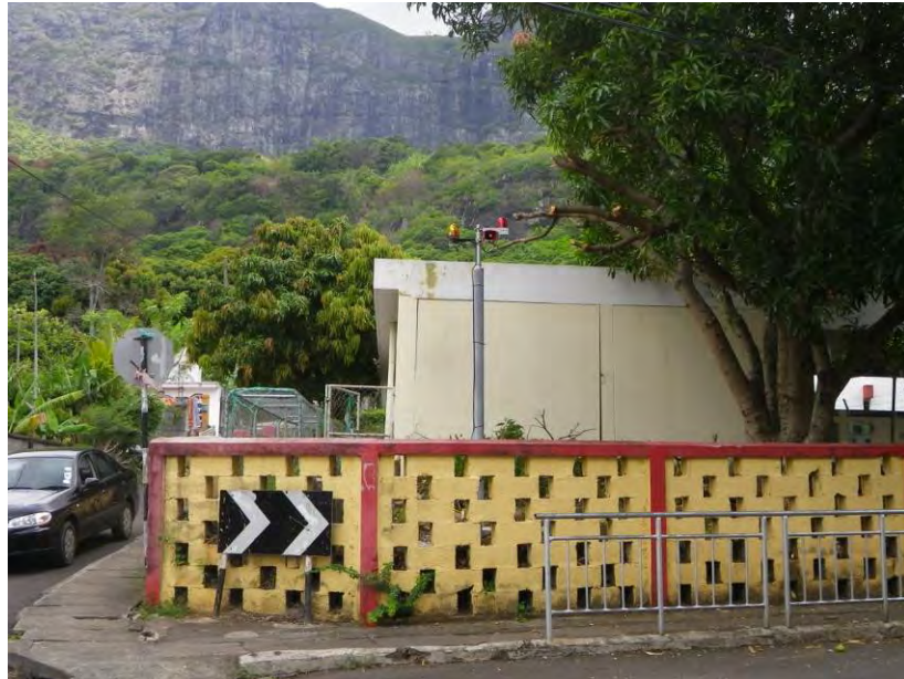
写真6.2.2 Chitrakoot 地区での早期警戒システムの設置状況(出典: JICA 調査団)
