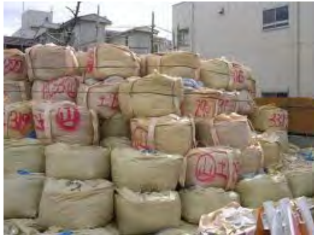
図5.2.13 地すべり対策としての土のうの例(出典:JICA 調査団)
