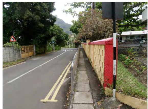
写真3.7.18 主要道路に面する擁壁と歩道 （出典：JICA 調査団）
