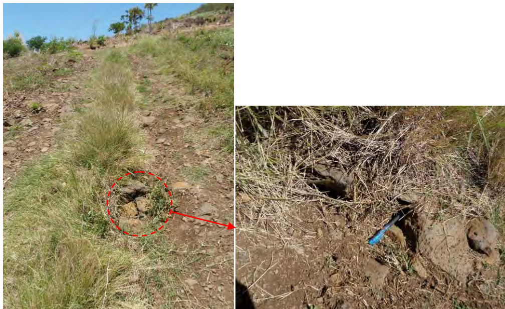
写真3.7.70 農道沿いの亀裂（出典：JICA 調査団）
