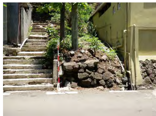
写真3.7.87 道路に面した石積み擁壁 (出典:JICA 調査団)
