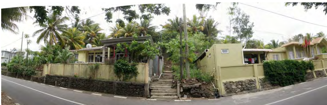
写真3.7.60 下部斜面(下方より撮影:斜面勾配 15~17° ) (出典:JICA 調査団)
