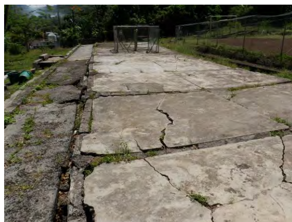
写真3.7.6 校舎基礎の床部分（西側）
