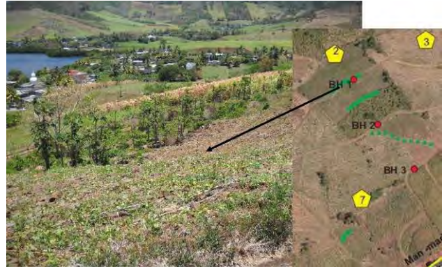
写真3.7.65 過去に確認された上部斜面の変状(既往報告書 No.2 より)
