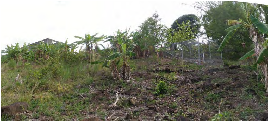
写真3.7.38 伸縮計 E(2)（下方から撮影）（出典：JICA 調査団）
