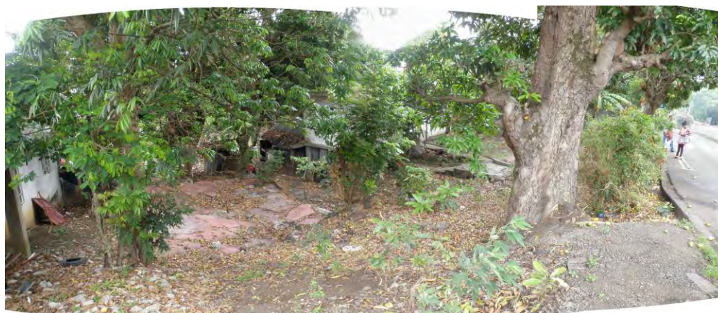
写真3.7.25 小学校前人家の変状（出典：JICA 調査団）
