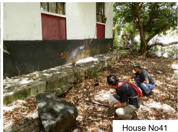
写真3.7.54 コンクリート基礎部分の空洞
