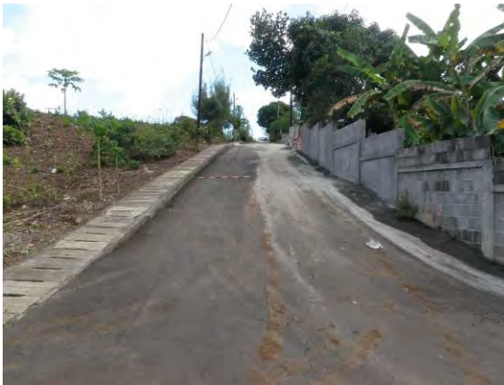
写真3.7.77 道路起点側の状況
