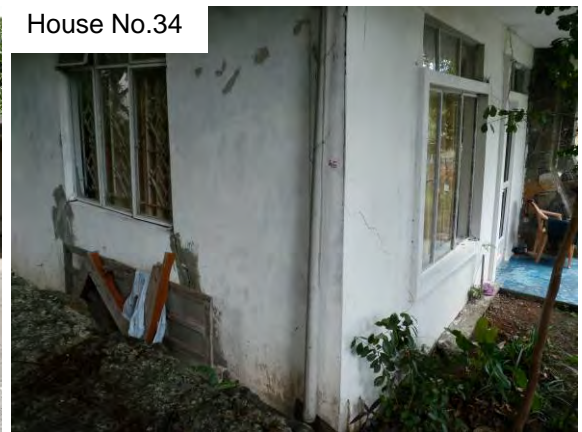
写真3.7.30 壁面(窓枠下)の亀裂
