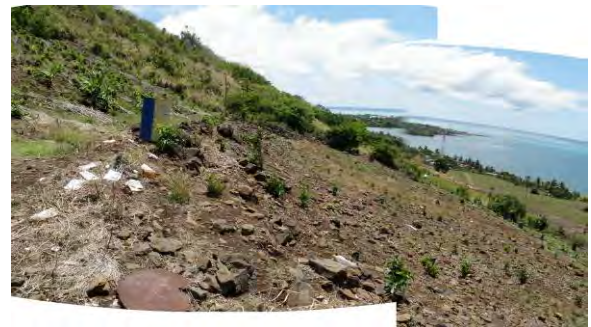
写真3.7.63 標高 70m 付近の斜面
