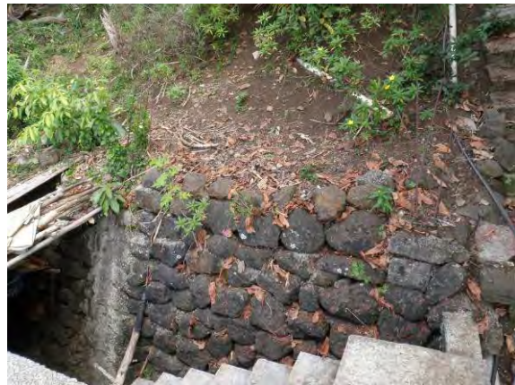
写真3.7.83 House19 背後の石積み擁壁（左：2011、右：現在）（出典：JICA 調査団）
