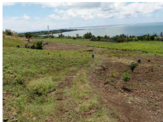
写真3.7.69 農道に発生した亀裂(上方より)
