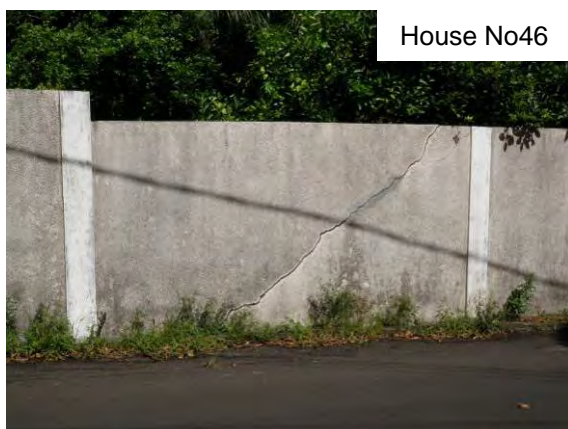
写真3.7.55 壁の亀裂
