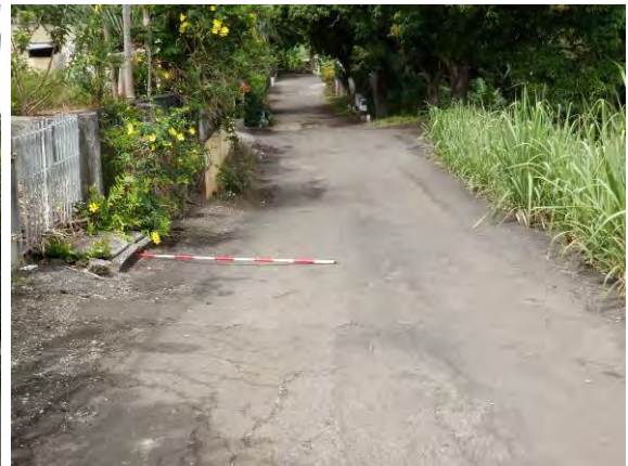
写真3.7.48 人家前の道路面
