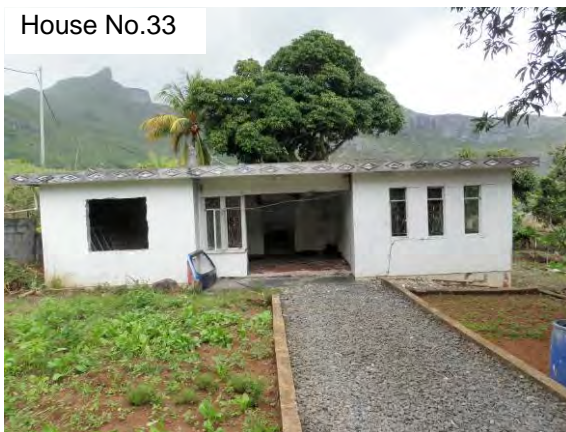
写真3.7.31 人家の傾斜(左側:沈下)
