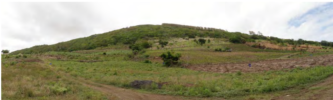
写真3.7.58 上部斜面(下方より撮影:斜面勾配 16~20° ) (出典:JICA 調査団)
