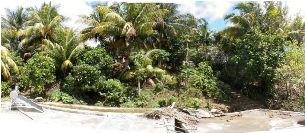
写真3.7.82 House19 の上部斜面（出典：JICA 調査団）
