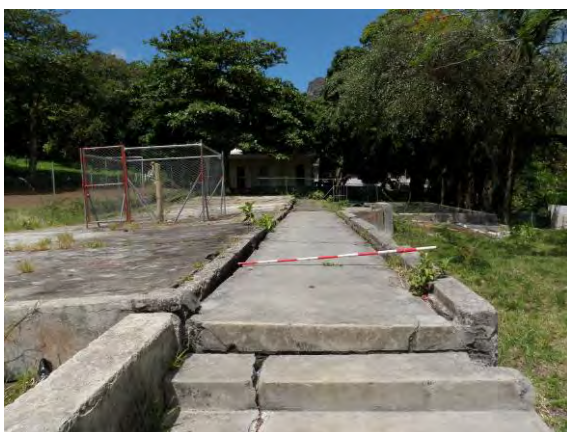
写真3.7.5 校舎基礎の階段部分（東側）
