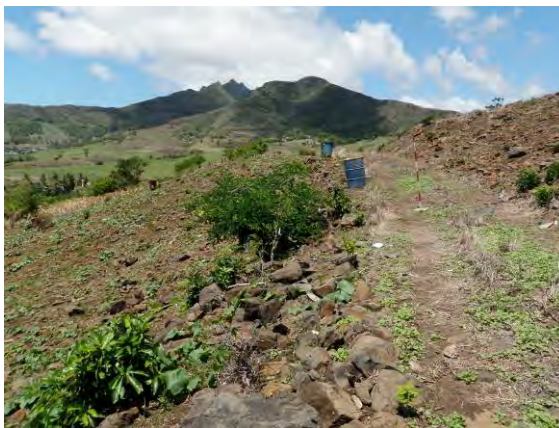
写真3.7.66 BH-1 付近の変状(現況)
