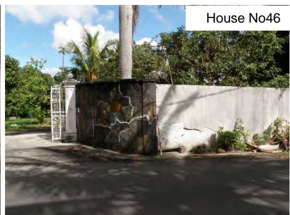
写真3.7.56 壁の亀裂(入口)
