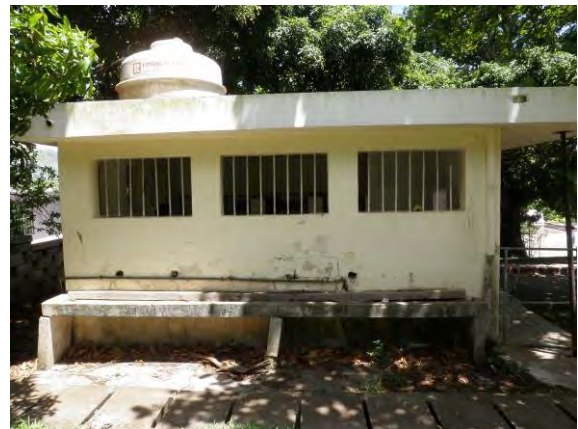
写真3.7.13 校舎西側の洗い場(House No.19) (出典: JICA 調査団)
