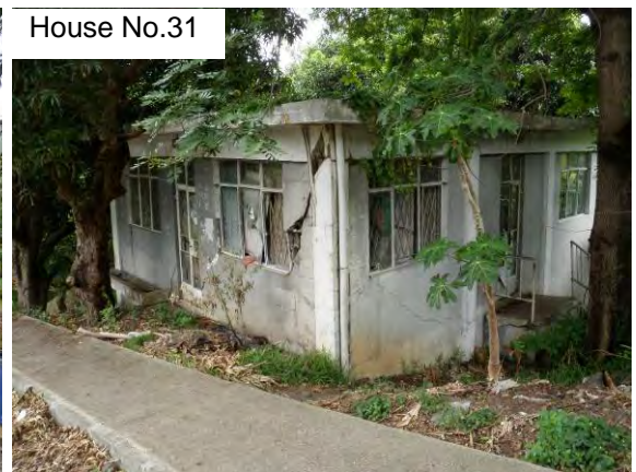
写真3.7.32 人家壁面の貫通亀裂
