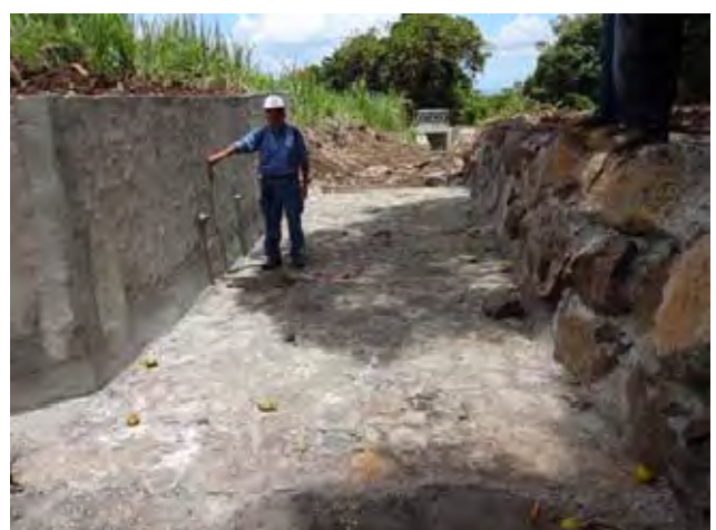
地すべり対策工の完成・水平ボーリング工 (パイロットサイト: Chitrakoot), 2014年12月12日
