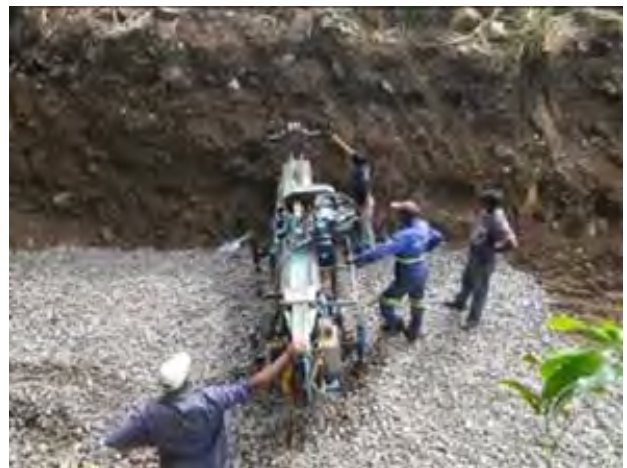
地すべり対策工施工・水平ボーリング技術指導 (パイロットサイト: Chitrakoot), 2014年10月30日
