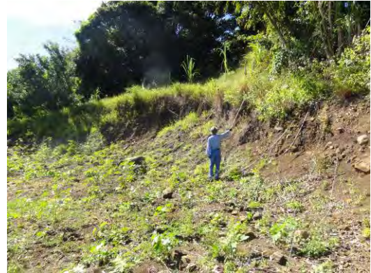
写真3.3.3 地すべり地内の滑落崖
