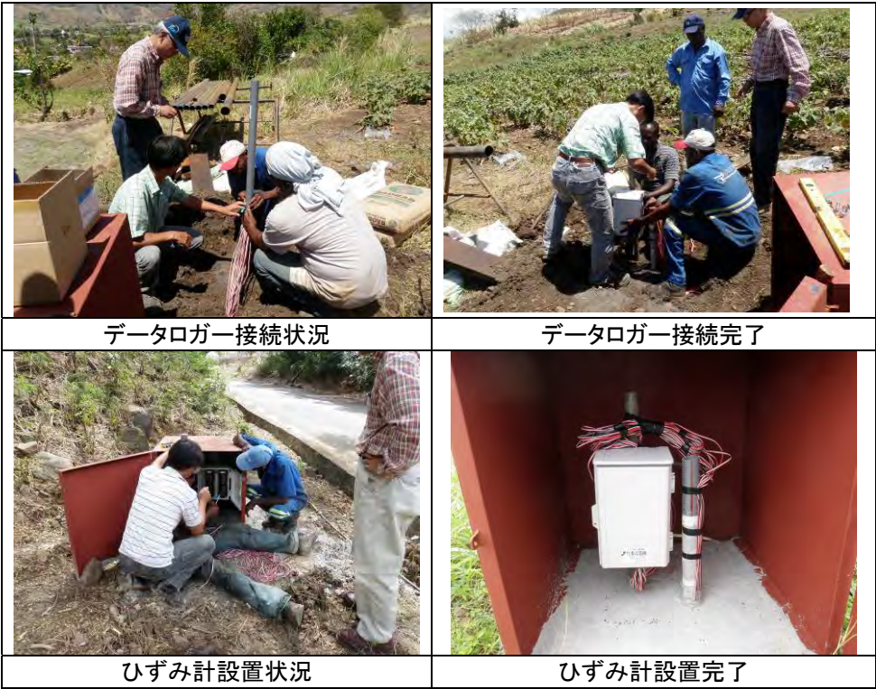
写真3.6.2 ひずみ計設置状況（出典：JICA 調査団）
