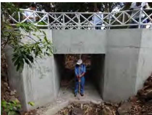
地すべり対策工の完成・橋梁Br-3 (パイロットサイト: Chitrakoot), 2014年12月12日
