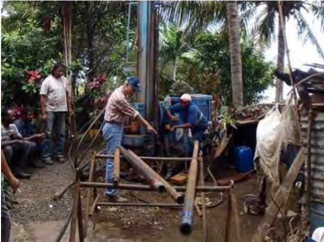
ボーリング調査の作業状況(Quatre Soeurs), 2012年10月2日
