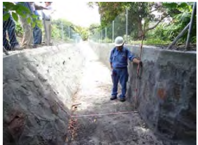
地すべり対策工の完成・水路工Type3 (パイロットサイト: Chitrakoot), 2014年12月12日
