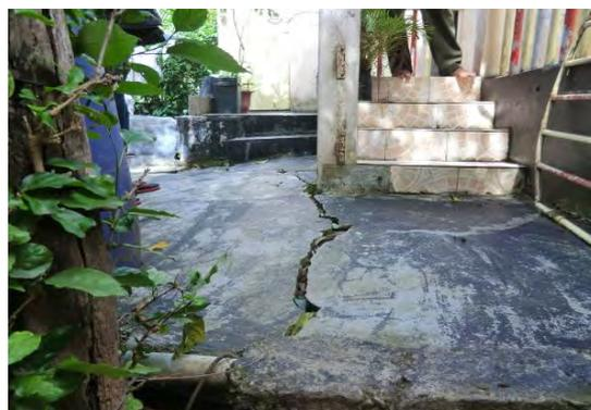
写真3.7.4 コンクリート基礎の開口亀裂
