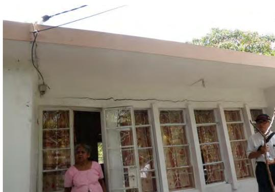
写真3.7.3 壁面に水平に延びた亀裂
