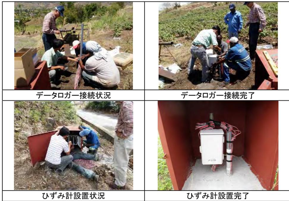
写真3.6.2 ひずみ計設置状況（出典：JICA 調査団）
