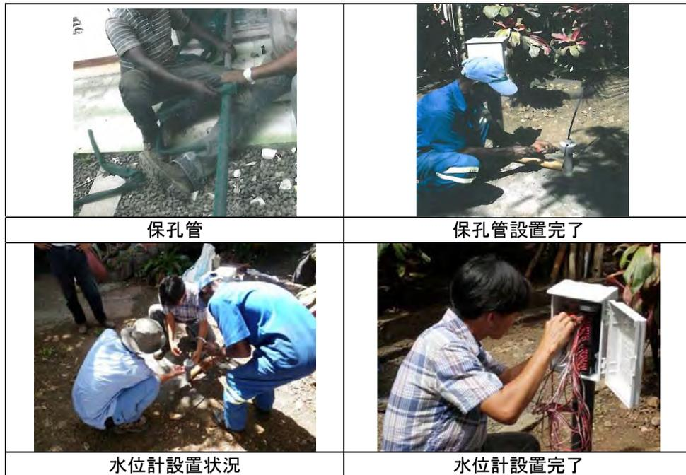
写真3.6.4 保孔管・水位計設置状況（出典：JICA 調査団）
