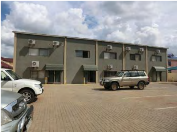
RDA 本部 施設は新しく、内装、外装の手入れも良く行き届いている。管理職が執務している。
