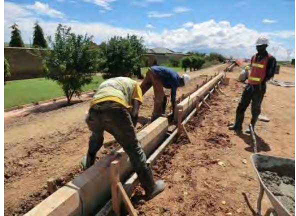
JICA 無償道路工事 ヘルメット、安全ベスト着用等の安全管理がなされている。
