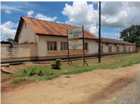
Kabwe Regional Office 建物は、古いが、施設を備えた会議室を有しており、OJT 講義等に使用できる。
