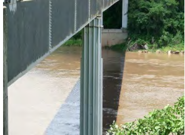
Luanguwa Br. 橋脚補強のため、鋼製スティフナーが追加されている。
