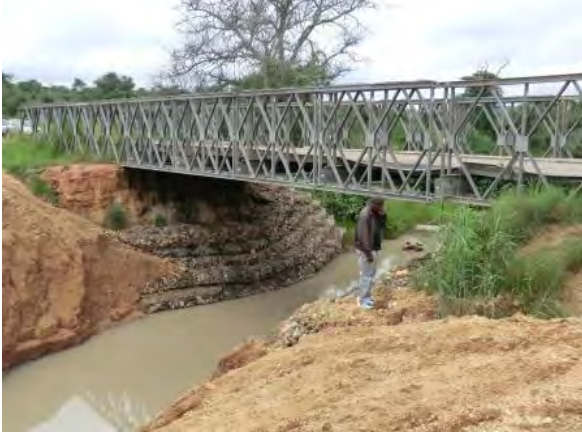
Baily Br. 洪水によって既設の橋梁が流されたため、簡易橋を架設し使用している。
