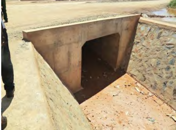
JICA 無償道路工事 カルバートボックス施工（品質は良い）
