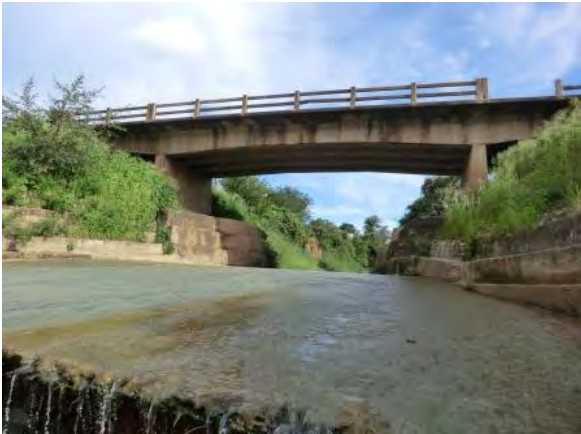
Nansenga Br. 橋長 35m (10+15+10) のカンチレバータイプ コンクリート桁橋
