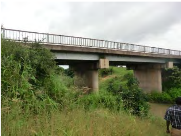
Kaleya Br. 1970 年代ユーゴスラビアによって建設され た 3 径間鋼桁橋
