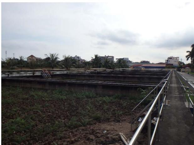
**写真-11：アンズオン浄水場天日乾燥床**
