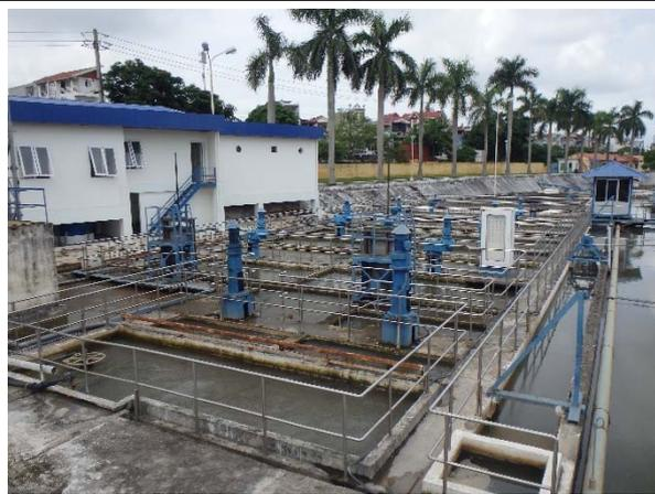
**写真-3：アンズオン浄水場薬品混和池/フロック形成池**
