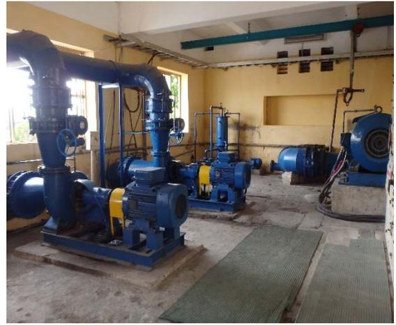
**写真-8：アンズオン浄水場逆洗ポンプ**
