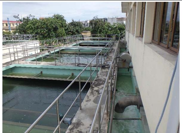
**写真-6：アンズオン浄水場急速ろ過池**
