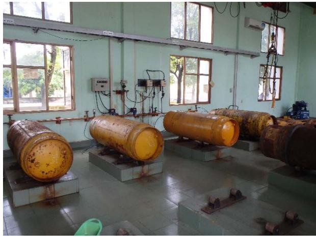
**写真-13：アンズオン浄水場塩素注入施設**
