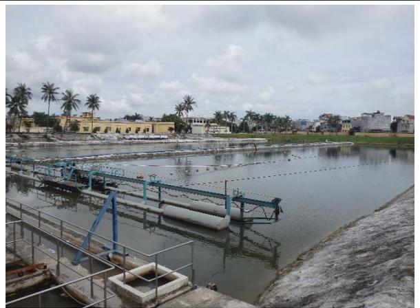
**写真-4：アンズオン浄水場沈澱池**
