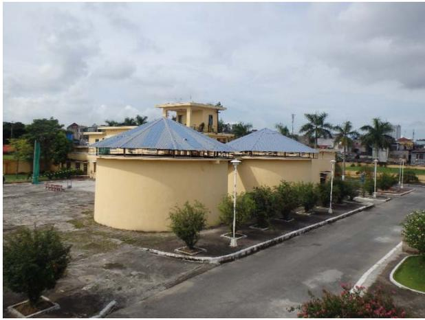
**写真-7：アンズオン浄水場逆洗用ろ過池**
