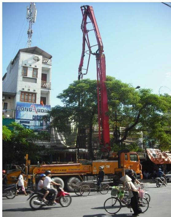
写真 3-2-4 コンクリート打設工事
