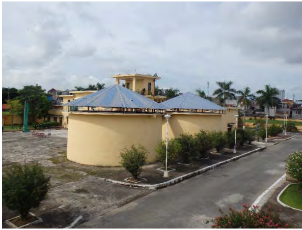
写真-7：アンズオン浄水場逆洗ろ過池
