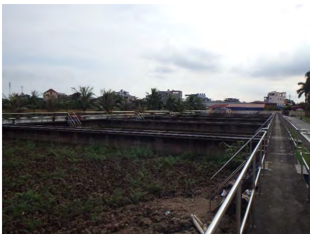
写真-11：アンズオン浄水場天日乾燥床
