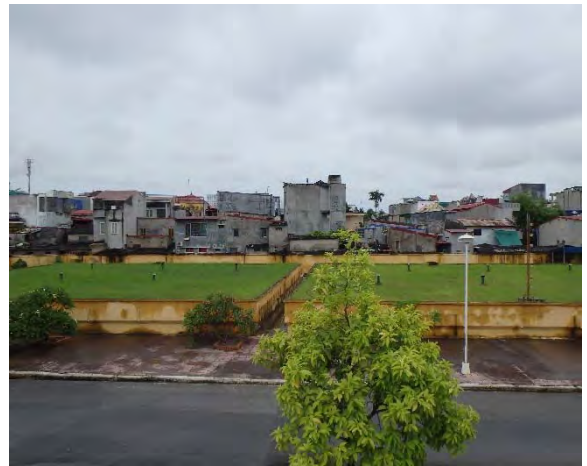
写真-10：アンズオン浄水場配水池
