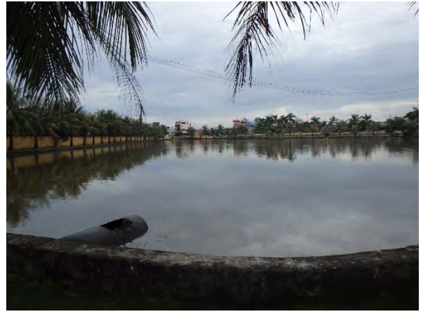
写真-2：アンズオン浄水場内の原水調整池（既設取水口より約4km） 取水口から導水された原水を原水調整池で受入れ、前沈澱池として利用している。面積12,000m 2 ×深さ4m。
