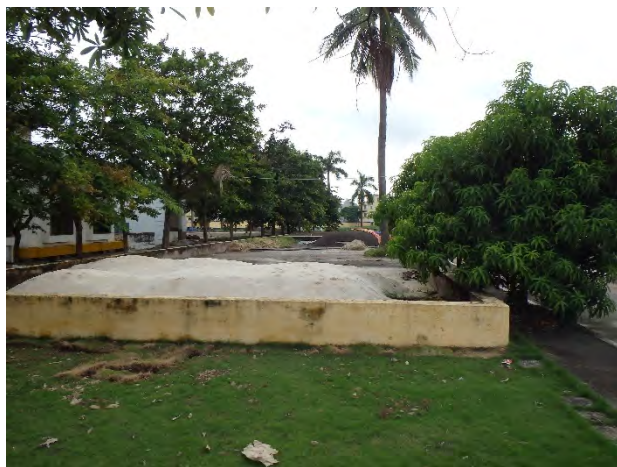
写真-17：アンズオン浄水場サンドベッド
