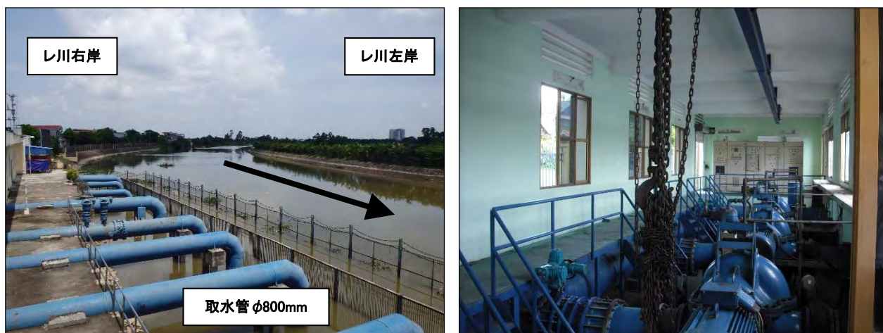
写真 2-1-1 クワンビン取水場
