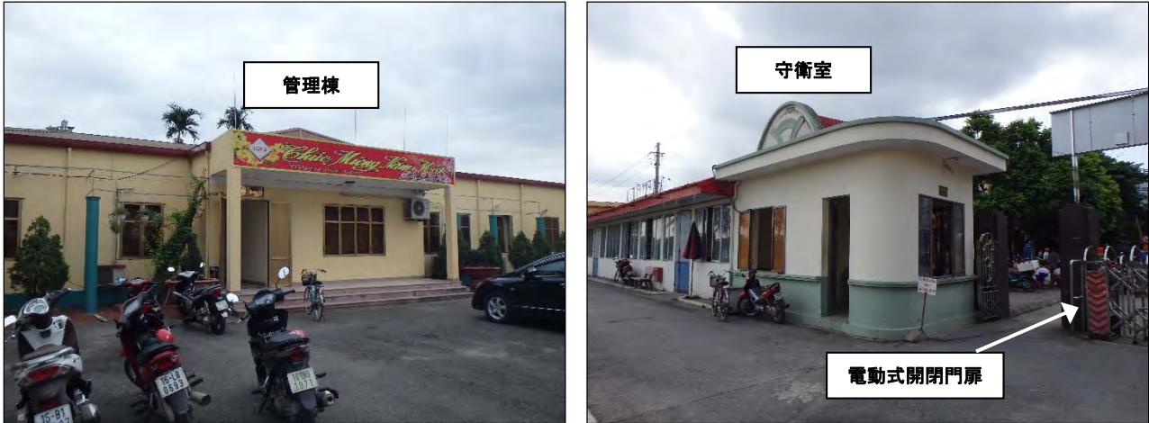
写真 2-1-18 管理棟/守衛室
