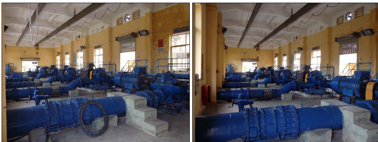
写真 2-1-11 配水ポンプ棟
