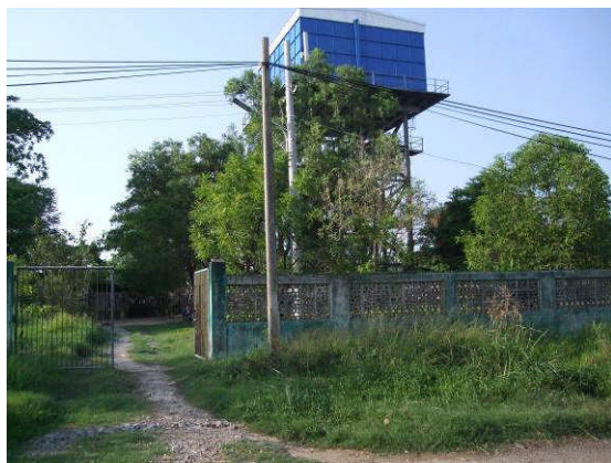
写真 - 5 塩素注入設備予定施設 (既存 No.2 高架水槽) マンダレー市における各配水拠点において塩素注入設 備を設置する。ポンプ場、高架水槽及び井戸施設を含め 合計で 9 箇所の既存配水拠点において塩素注入設備を 設置する。
