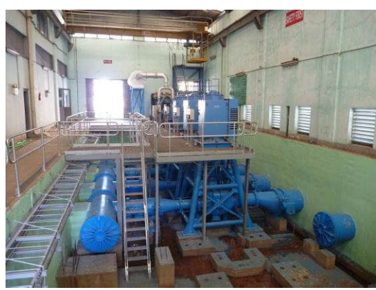
写真 - 6 塩素発生設備予定施設 (既存 No.1 配水ポンプ 場) No.1 及び No.7 配水ポンプ場に塩素発生設備を計画す る。この設備で塩素が生成され、マンダレー市内の各既 存配水拠点とピジータゴンタウンシップへの新規上水 道システムにおいて注入される。
