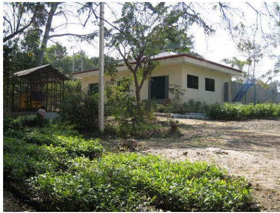
写真 - 3 No.7 配水ポンプ場 同場内には既設配水池及び配水ポンプ場がある。これら 既存施設に隣接する形で配水池、配水ポンプ場及び塩素 消毒施設を新設し、ピジータゴンタウンシップの未給水 地区に給水を実施する。
