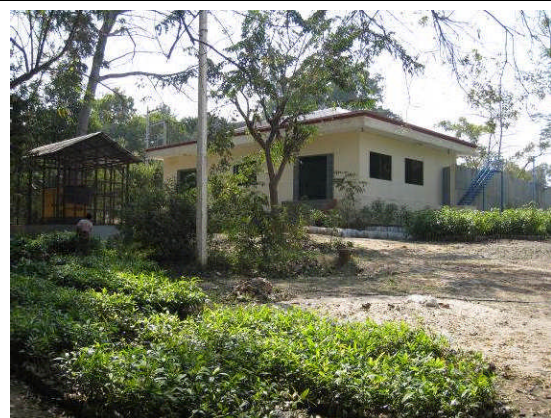
写真-3 No.7 配水ポンプ場 同場内には既設配水池及び配水ポンプ場がある。これら 既存施設に隣接する形で配水池、配水ポンプ場及び塩素 消毒施設を新設し、ピジータゴンタウンシップの未給水 地区に給水を実施する。
