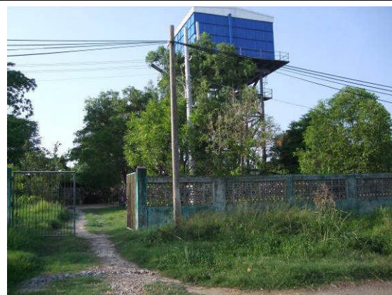
写真-5 塩素注入設備予定施設 (既存 No.2 高架水槽) マンダレー市における各配水拠点において塩素注入設 備を設置する。ポンプ場、高架水槽及び井戸施設を含め 合計で 9 箇所の既存配水拠点において塩素注入設備を 設置する。
