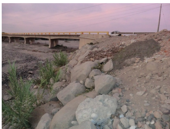
Río Pisco (protección de márgenes con mampostería ciclópea)
