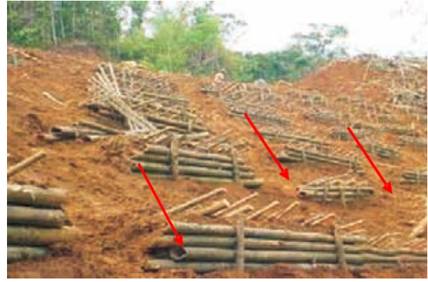
Obra de dissipador de energía de talud ※ 1 (Chosica)
