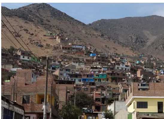
Figura 3.3.8 Viviendas vulnerables a los sismos
