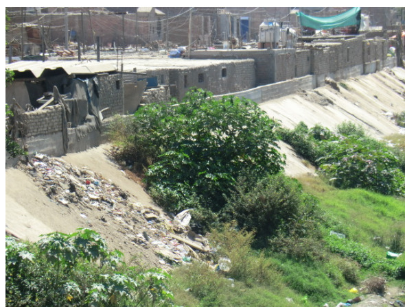
Río Ica (protección de márgenes con revestimiento de hormigón)
