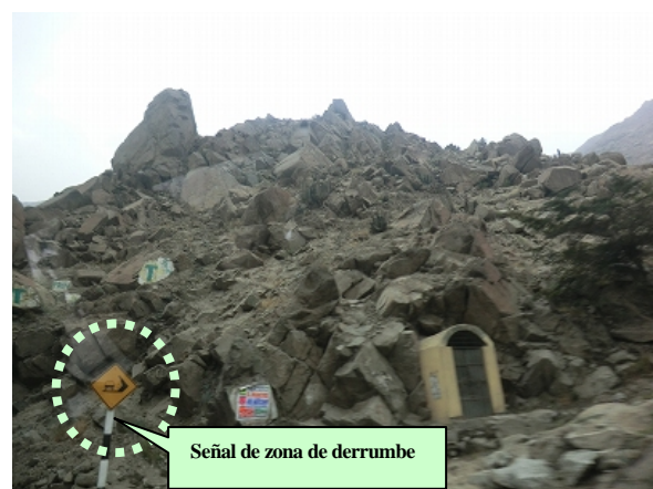
Señal de zona de derrumbe colocada en la vía. (Sin embargo, no se ha instalado ni cerco protector ni paredes.)
