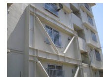
Trabajo de reforzamiento antisísmico de casa convencional
