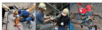
Ejemplo de caso de reforzamiento implementando el pretensado a la pared de ladrillo
