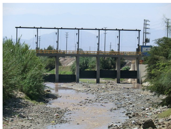
写真 A4.3.4 Ica 川(取水堰) (2014 年 5 月 5 日)
