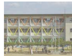
Trabajo de reforzamiento antisísmico
