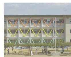
Trabajo de reforzamiento antisísmico
