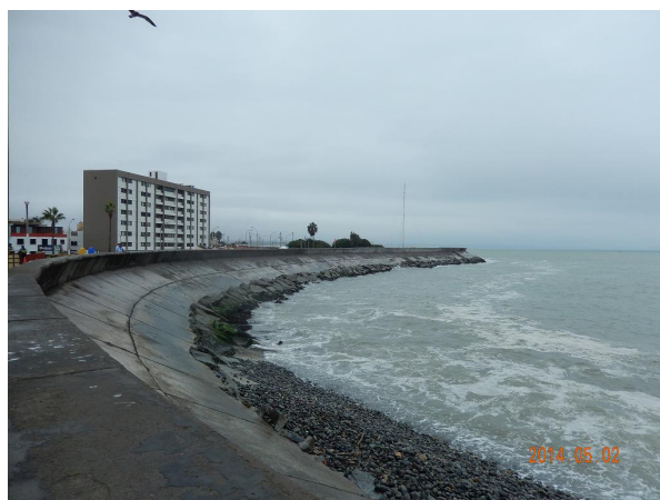
写真 A4.3.2 Callao 市先端にある海岸堤防・護岸 (2014 年 5 月 2 日)
