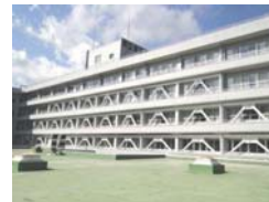
Hospital con obras de renovación antisísmica (Japón)
