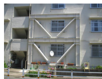
Reforzamiento de tubería de acero
