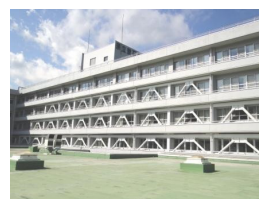
Hospital con obras de renovación antisísmica(Japón)
