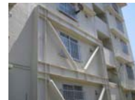
Trabajo de reforzamiento antisísmico de casa convencional
