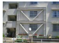
Reforzamiento de tubería de acero
