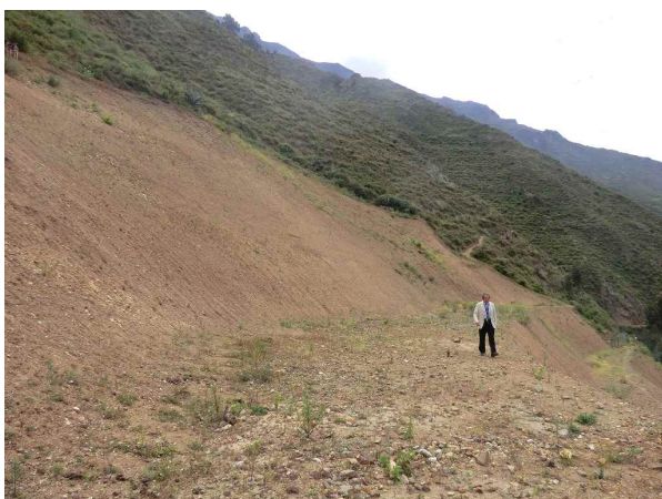
写真 A4.3.1 San Mateo 町 2010 年地すべり発生箇所 (法面整正済: 2014 年 4 月 29 日)
