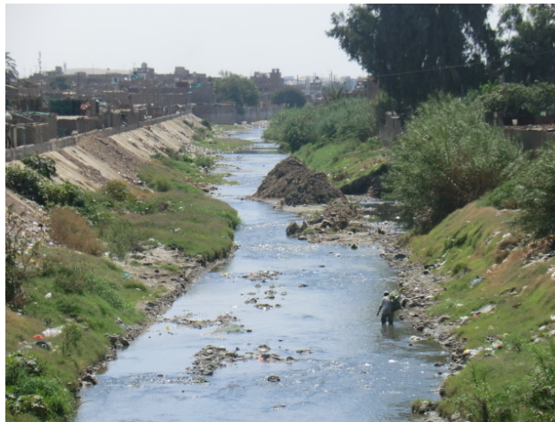
図 4.4.1 州政府等により全体計画無しに進められた河川の護岸工事と洪水に対し脆弱な堤内の稠密な住宅地
