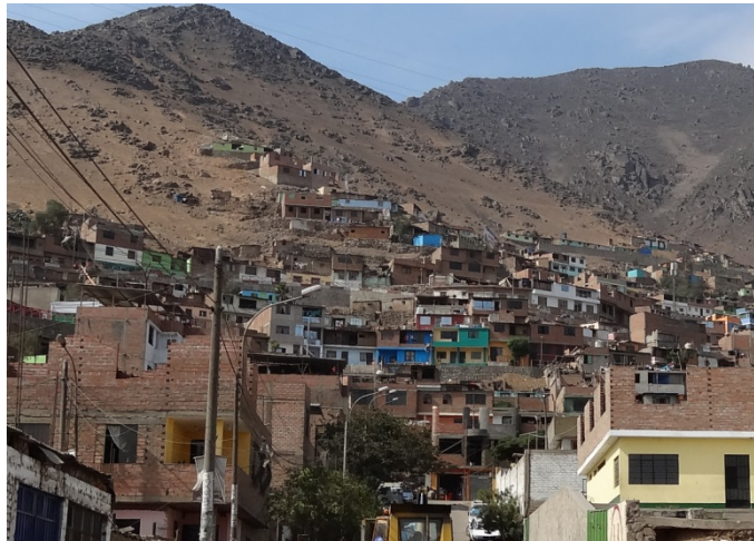
図 3.3.8 地震災害に脆弱な既存住宅の状況
