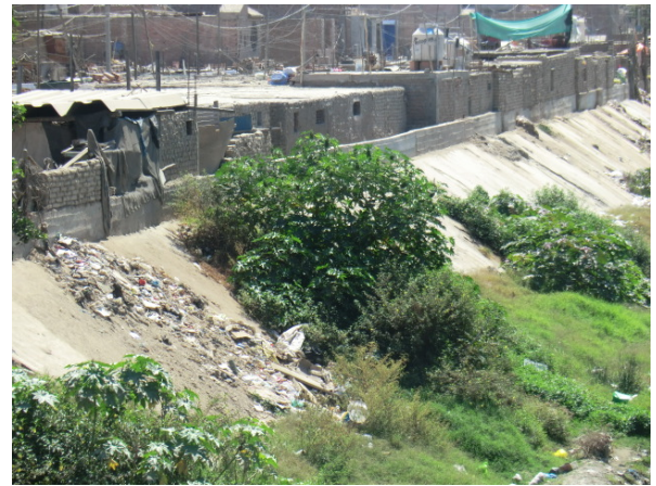
Ica 川（コンクリート張護岸）
