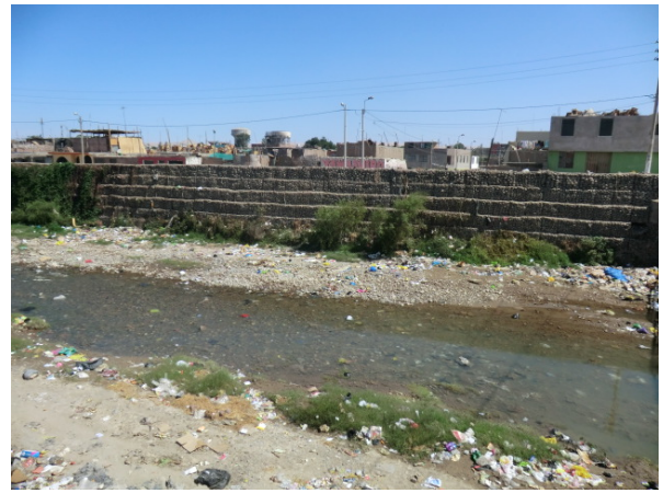
Ica 川（フトン籠護岸）：Ica 市内は下流にいくほど 河川幅が狭くなる
