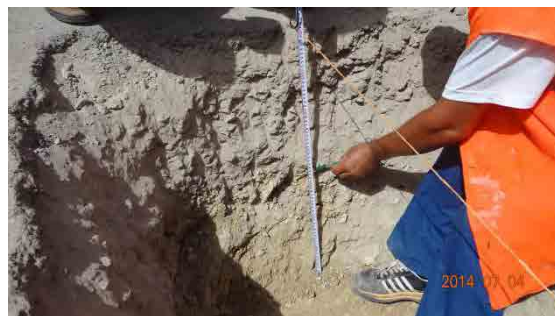
試掘断面（深さ 63cm、路床厚 33cm）
