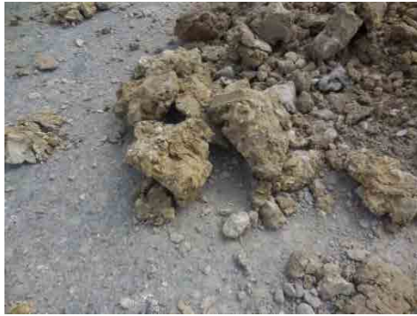
砂+砂利のセメント安定処理路盤
