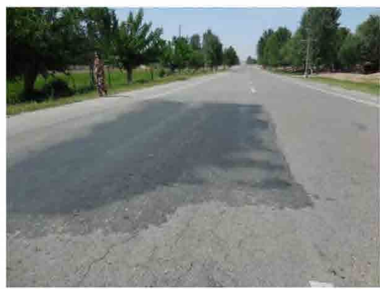
AC 舗装破損個所の常温合材による補修状況
