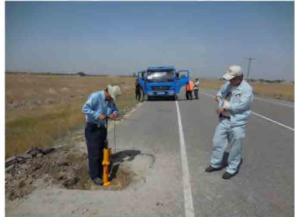
簡易 CBR 試験機試験状況
