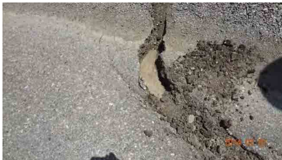
図 2.19-4 勾配部滑動面測定箇所
