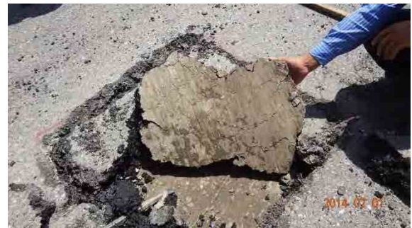
図 2.19-4 勾配部滑動面測定箇所
