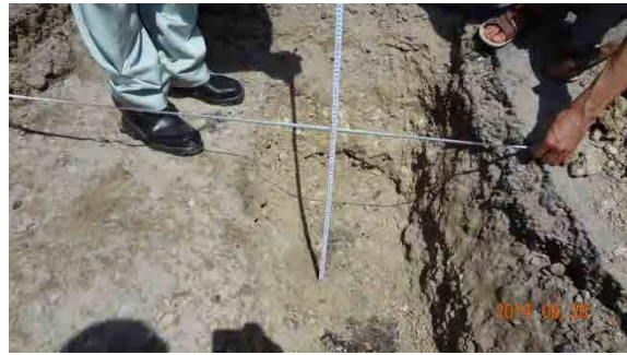
④試掘断面 (深さ 30 cm、粘性土厚さ 20 cm)
