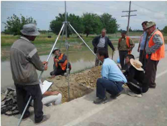
簡易動的コーン貫入試験状況
