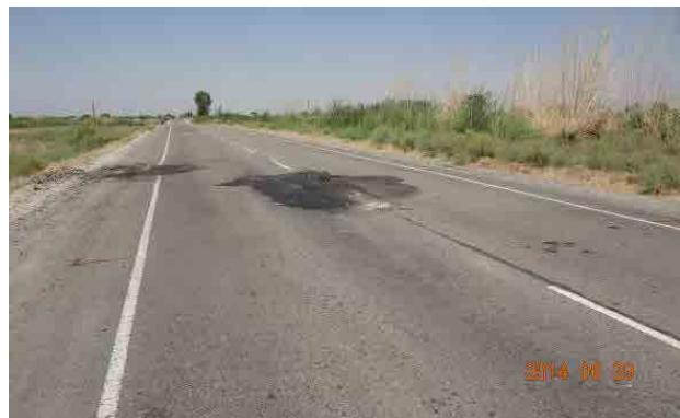
調査対象道路の現況写真 (1/2) (舗装破損部)
