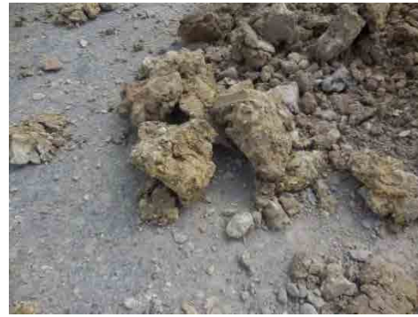
粘性土のセメント安定処理路盤
