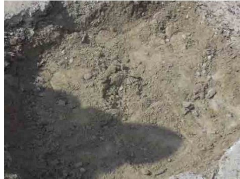
粘性土のセメント安定処理路盤
