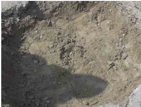
砂+砂利のセメント安定処理路盤の現状
