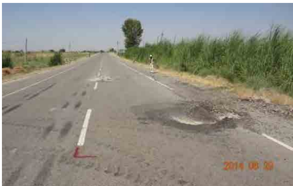
調査対象道路の現況写真 (1/2) (舗装破損部)
