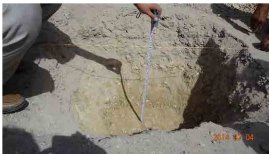
試掘断面（深さ 63cm、路床厚 33cm）
