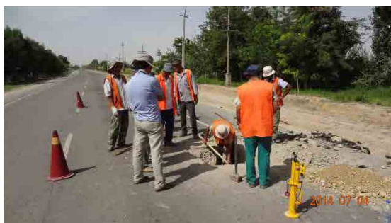
掘削作業状況
