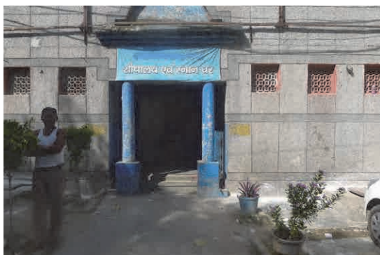
写真1：公衆トイレ概観
