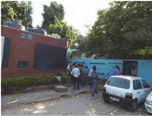
写真7 公衆トイレ概観
