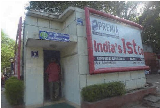
写真5 公衆トイレ概観
