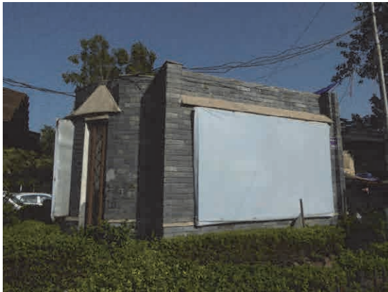
写真7 公衆トイレ概観
