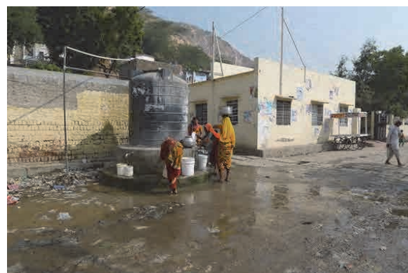
スラム地区の共同タンク。排水路がなく、道路が水浸しになっている。（2014年11月13日訪問のジャイプール市内のスラム地区）
