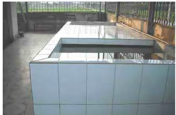
出荷調整施設（野菜洗い場）
