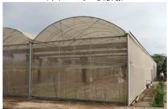
プロジェクトで供与した保護栽培網室 (トゥ・リエム試験場)
